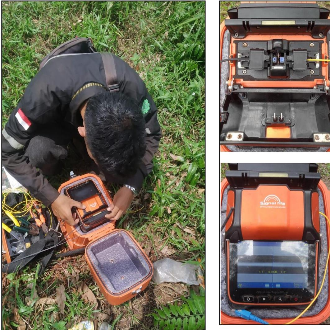
Gambar 4.1 Penyambungan dan pengecekan.
