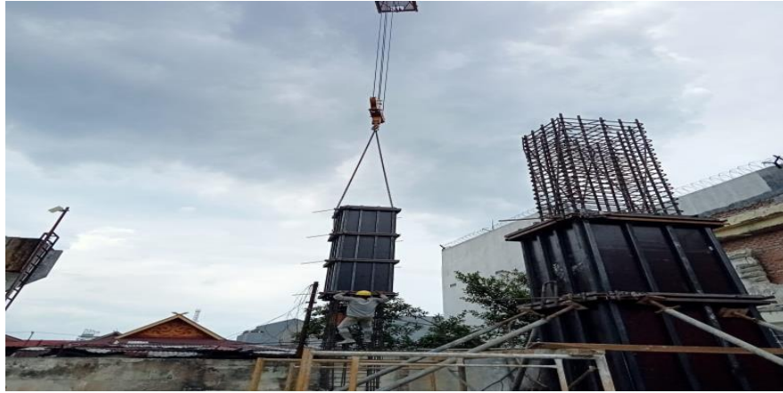
Gambar 3. 17 Proses Pemasangan Bekisting Kolom
