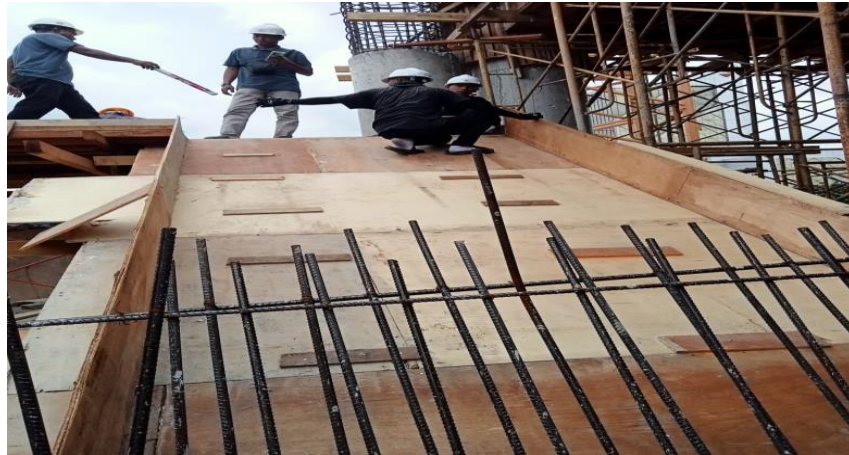
Gambar 3. 30 Pemasangan Bekisting
