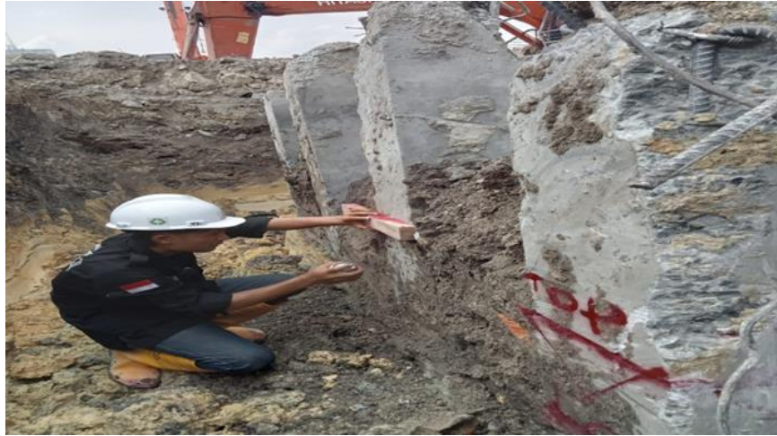
Gambar 3. 2 Pengukuran Top LC
