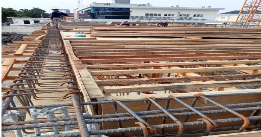
Gambar 3. 23 Pekerjaan pembesian
