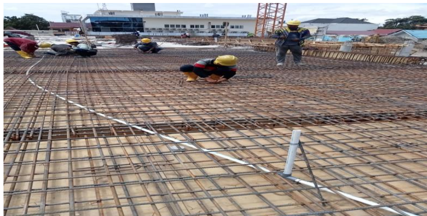
Gambar 3. 27 Pekerjaan pembesian
