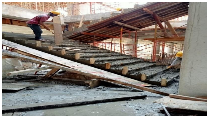
Gambar 3. 33 Pembongkaran Bekisting
