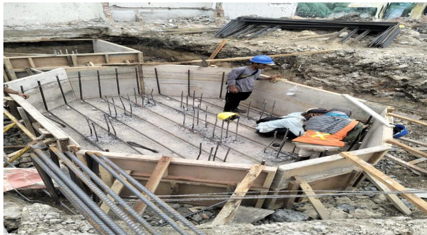
Gambar 3. 8 Proses penulangan
