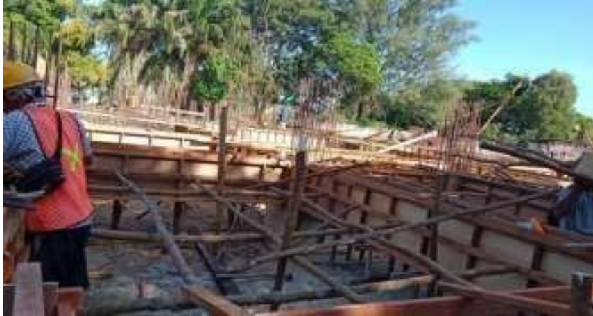
Gambar 3. 13 Pemasangan Bekisting
