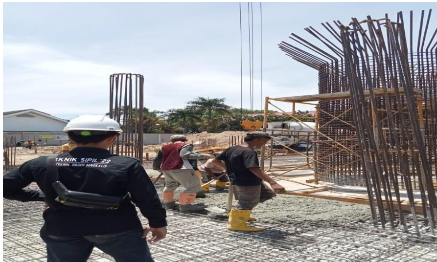
Gambar 3. 4 Pengawasan Elevasi Pengecoran
