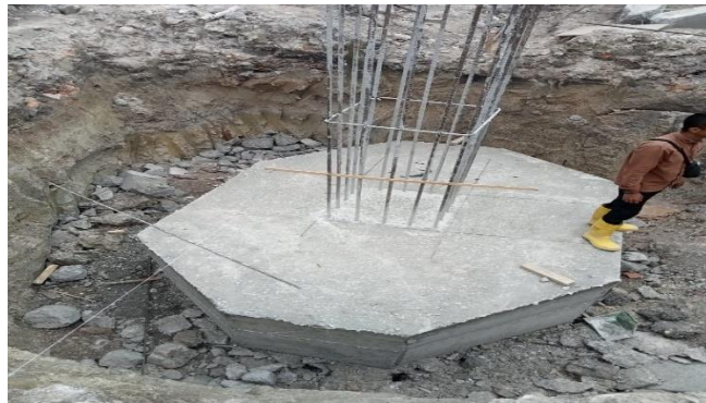
Gambar 3. 10 Proses Pembongkaran Bekisting
