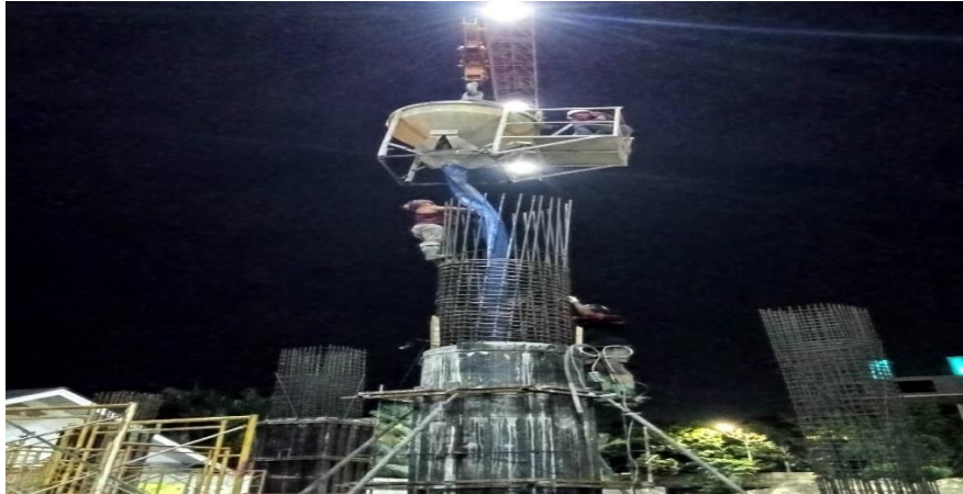
Gambar 3. 18 Pengecoran Kolom
