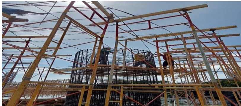
Gambar 3. 21 Pemasangan perancah scaffolding
