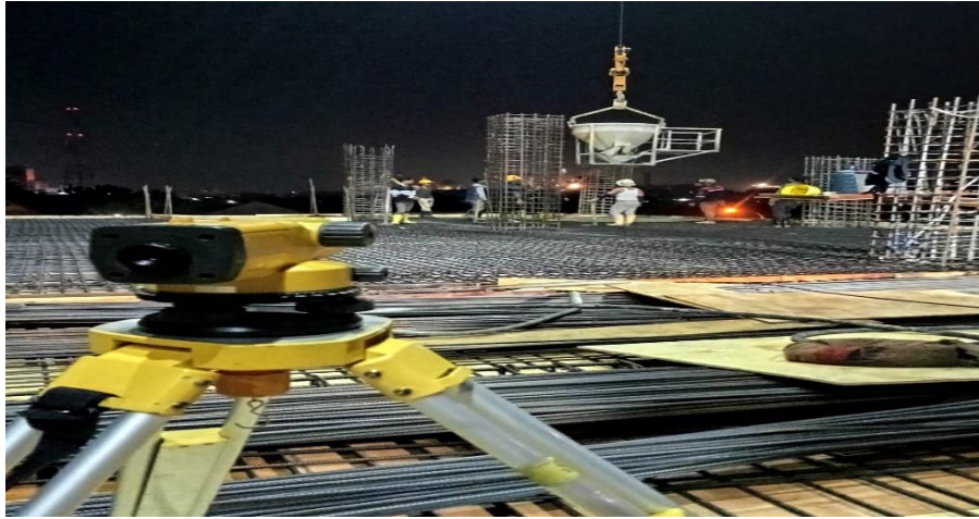
Gambar 3. 5 Pengukuran elevasi pengecoran
