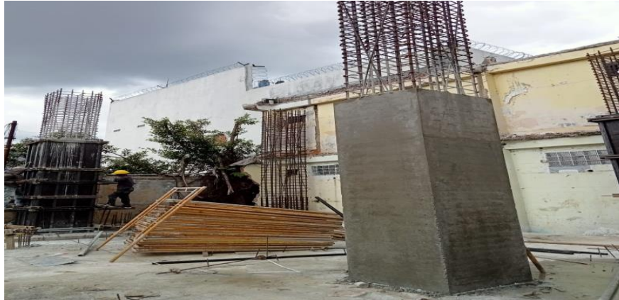
Gambar 3. 19 Pembonkaran Bekisting Kolom
