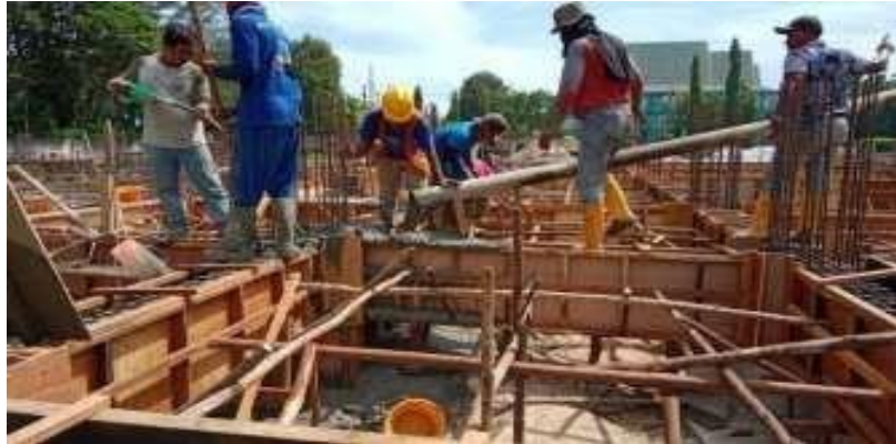
Gambar 3. 14 Proses Pengecoran Balok Sloof ( Sumber : Dokumentasi Lapangan 2024)
