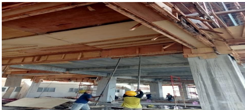
Gambar 3. 29 Pembongkaran Bekisting ( Sumber : Dokumentasi Lapangan 2024)
