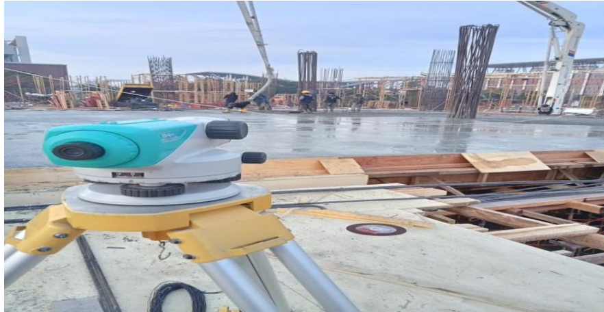
Gambar 3. 28 Pengecoran ( Sumber : Dokumentasi Lapangan 2024)
