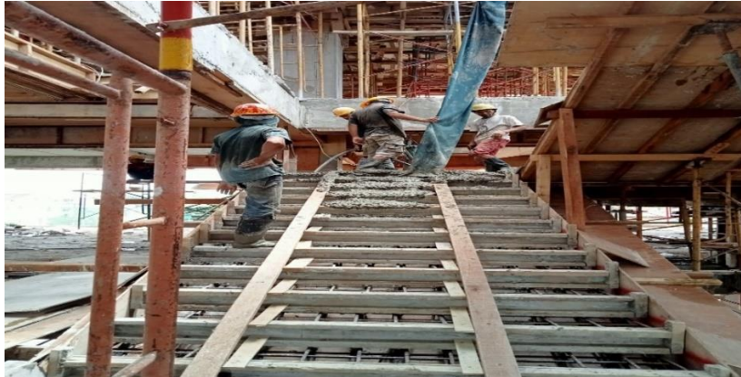
Gambar 3. 32 Pengecoran tangga
