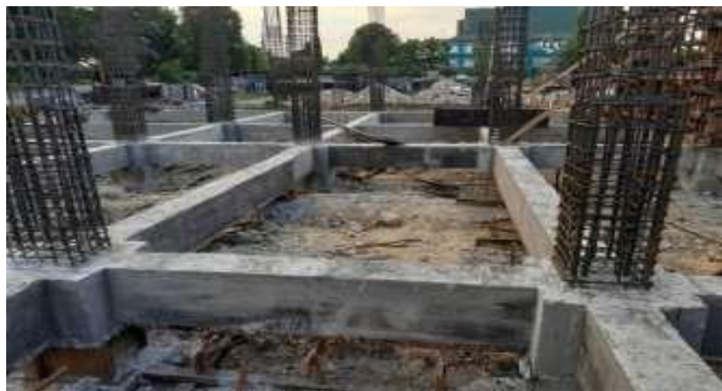
Gambar 3. 15 Pembongkaran Bekisting ( Sumber : Dokumentasi Lapangan 2024)
