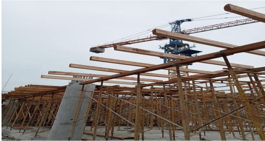
Gambar 3. 25 Pemasangan Perancah
