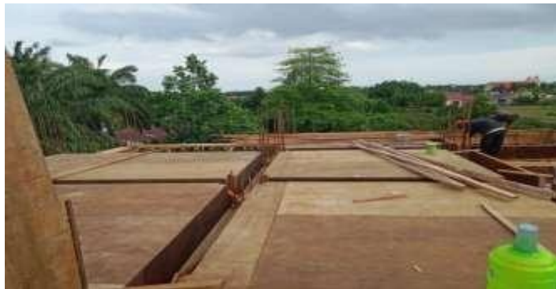
Gambar 3. 26 Pemasangan Bekisting ( Sumber : Dokumentasi Lapangan 2024)
