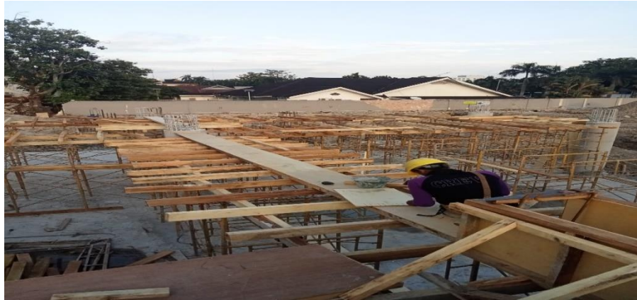
Gambar 3. 22 Pemasangan Bekisting
