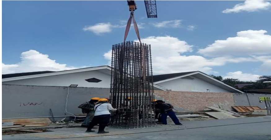
Gambar 3. 16 Proses Penulangan Kolom
