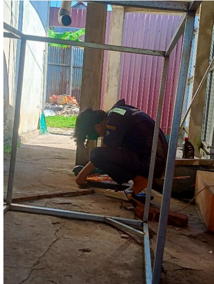
Gambar 4. 3 Pemotongan Material
