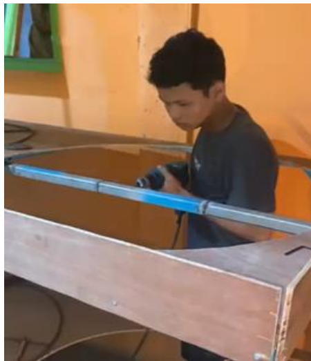
Gambar 4. 6 Pembuatan Kedudukan Bearing
