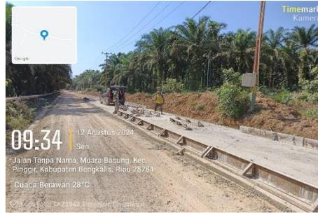
*Gambar 4. 11 Pemasangan Bekisting
