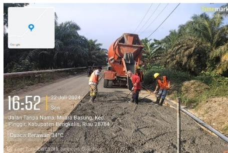
*Gambar 3. 13 Pengecoran LC
