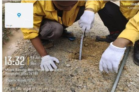
*Gambar 3. 9 Pengujian Core Base*
