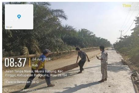
*Gambar 3. 15 Pemasangan Bekisting rigid
