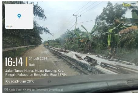
*Gambar 4. 27 Pembongkaran Bekisting
