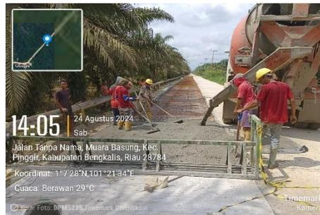
*Gambar 4. 21 Penuangan Beton
