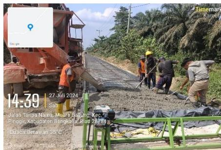
*Gambar 3. 17 Pengecoran Rigid
