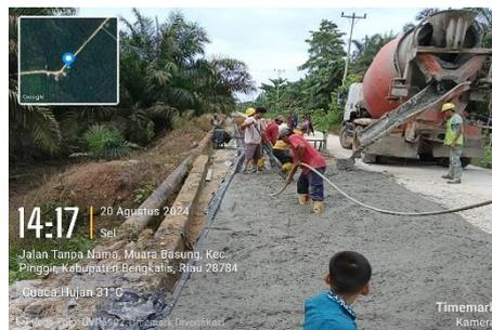
*Gambar 4. 22 Pemasatan Beton
