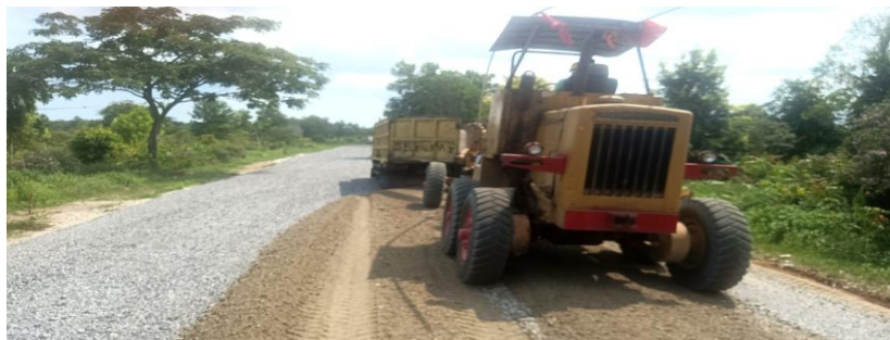
Gambar 2. 1 Dokumentasi Lapangan Sumber : dokumentasi pribadi
