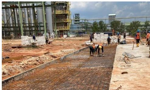
**Gambar 3. 17** Proses Pemasangan Weremesh
