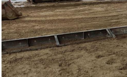
**Gambar 3. 16** Proses Pemasangan Bekesting
