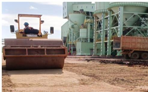
**Gambar 3. 13** Proses pemadatan Material Quarry waste
