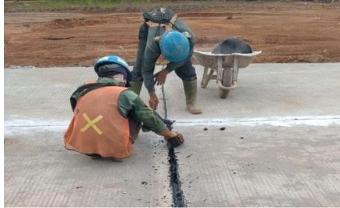
**Gambar 3. 23** Proses Penuangan Join Sealant
