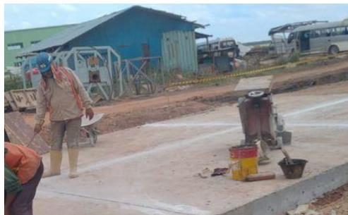
**Gambar 3. 22** Proses Pemotongan Beton
