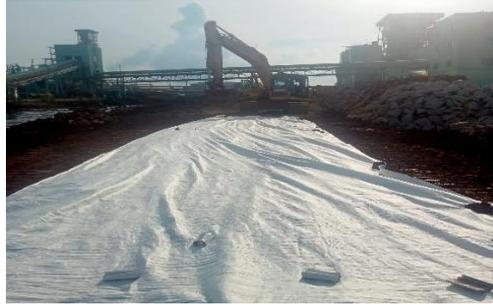
**Gambar 3. 11** Proses Pembentangan Kain Geotekstil
