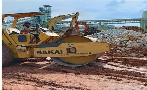
**Gambar 3. 9** Proses Pemadatan Tanah
