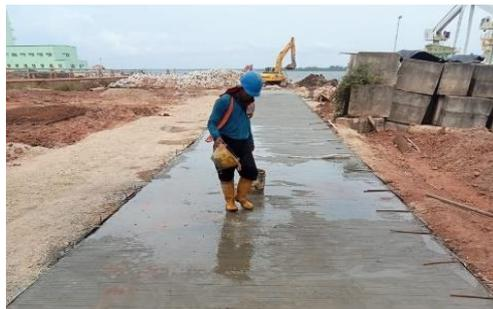
**Gambar 3. 24** Perawatan beton
