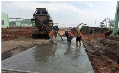
**Gambar 3. 20** Proses Pengecoran Manual
