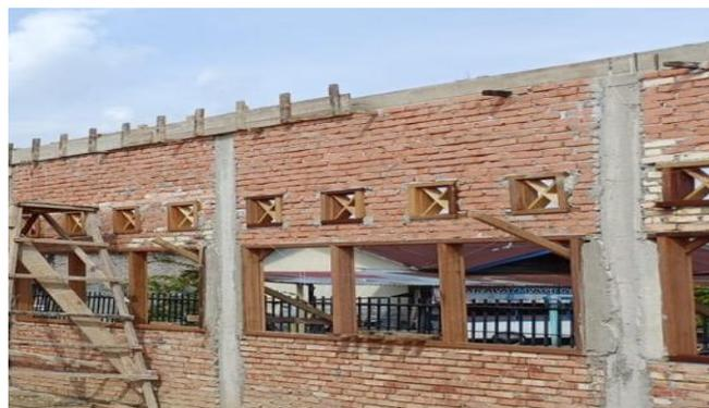
Gambar 3. 22 Pemasangan Bekisting Balok
