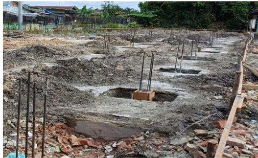
Gambar 3. 10 Pemasangan Bekisting Kolom Pedestal
