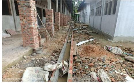
Gambar 3. 78 Pekerjaan plasteran saluran air
