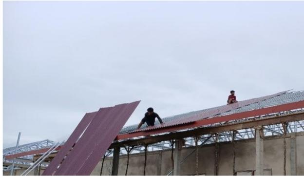
Gambar 3. 63 Pemasangan Atap Long Spandek
