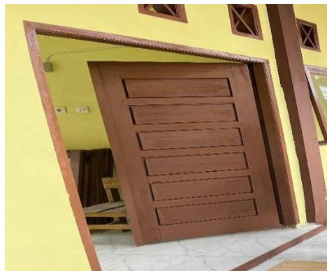
Gambar 3. 33 Pemasangan Pintu Panel
