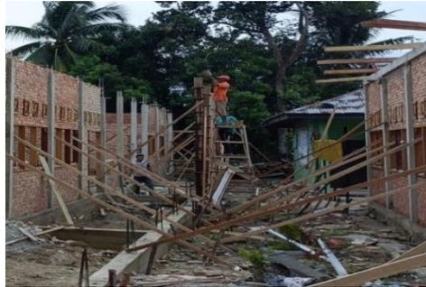
Gambar 3. 21 Pengecoran Kolom Praktis
