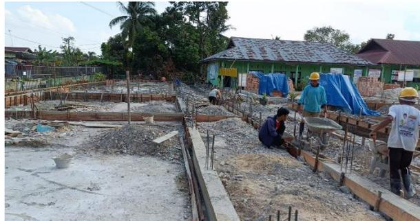
Gambar 3. 14 Pengecoran Sloof
