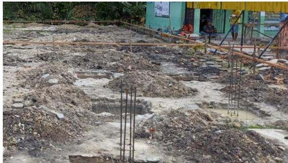
Gambar 3. 6 Pengecoran Pondasi Setempat
