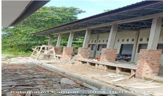
Gambar 3. 59 Pembuatan Bekisting Tempat Duduk
