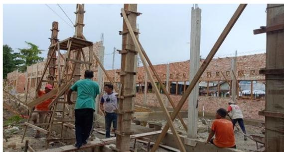
Gambar 3. 20 Pemasangan Bekisting Kolom Praktis
