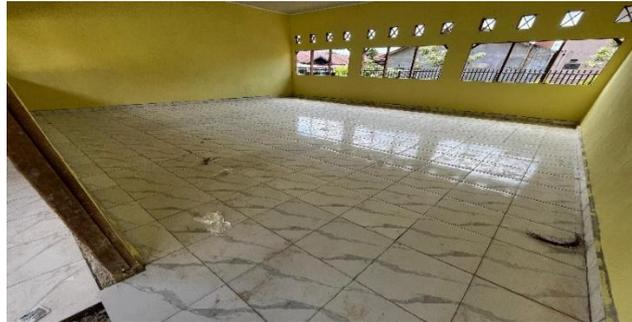
Gambar 3. 54 Pemasangan Plint Keramik
