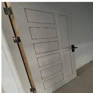
Gambar 3. 35 Pemasangan Engsel Pintu
