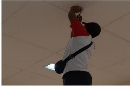
Gambar 3. 74 Pemasangan Lampu Down Light
