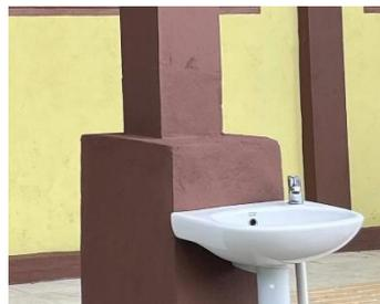
Gambar 3. 83 Pemasangan Tempat Cuci Tangan
