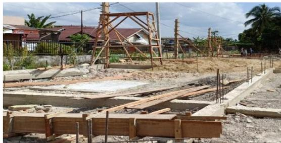
Gambar 3. 16 Pemasangan Bekisting Kolom
