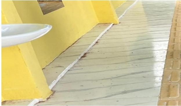
Gambar 3. 57 Pemasangan plint keramik
