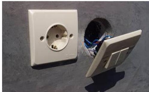
Gambar 3. 70 Pemasangan Stop Kontak
