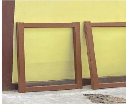
Gambar 3. 46 Pengecatan Bingkai Jendela
