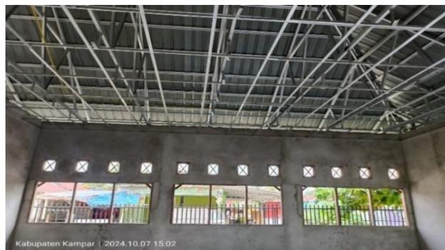
Gambar 3. 66 Pemasangan Rangka Hollow
