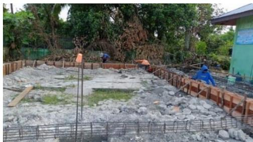
Gambar 3. 13 Pemasangan Bekisting Sloof
