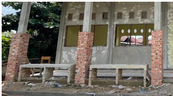
Gambar 3. 60 Pengecoran Tempat Duduk
