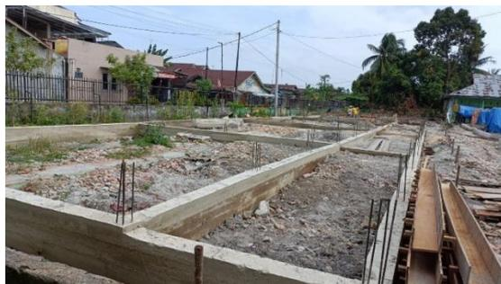
Gambar 3. 15 Pembongkaran bekisting
