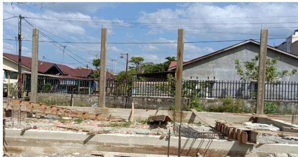
Gambar 3. 19 Pembongkaran Bekisting Kolom
