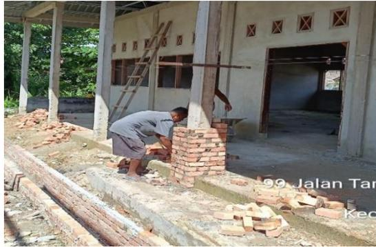
Gambar 3. 27 Pemasangan Bata Kolom
