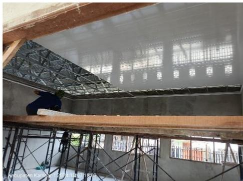
Gambar 3. 67 Pemasangan Plavon PVC
