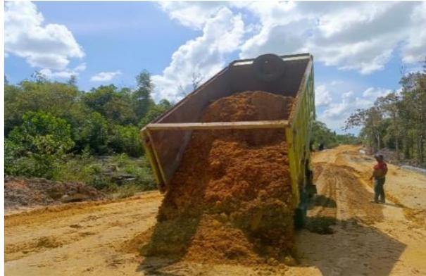
Gambar 3. 11 (Pekerjaan Penghamparan Tanah Timbunan)
