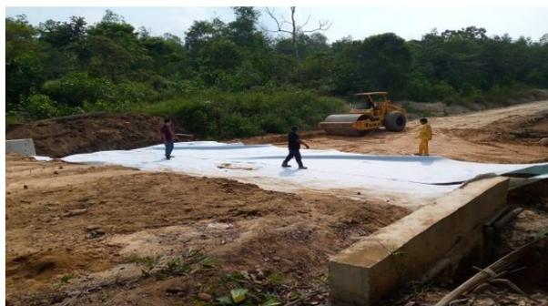
*Gambar 3. 8(Pemasangan Geotextile)
