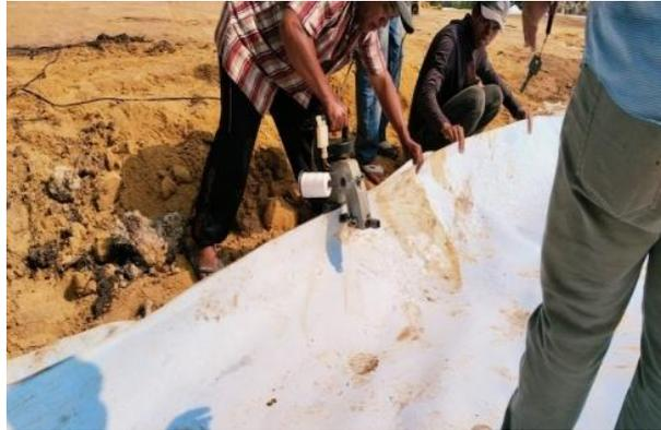
*Gambar 3. 9 (Penjahitan Geotextile)
