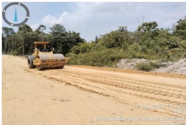
Gambar 3. 12 (Pekerjaan Pemadatan Tanah Timbunan)
