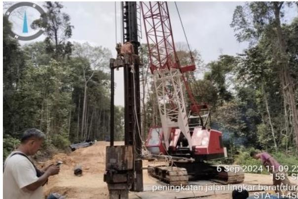
*Gambar 3. 13 (Pekerjaan Persiapan Alat Pancang)
