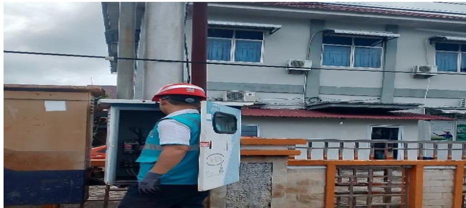
Gambar 2. 4 Pemutusan Sementara pada Penerangan Jalan Umum
