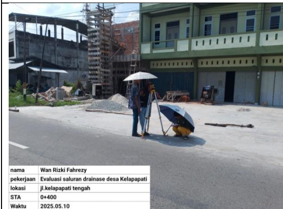
Survey Pengambilan Data Penampang Saluran STA 0+400
