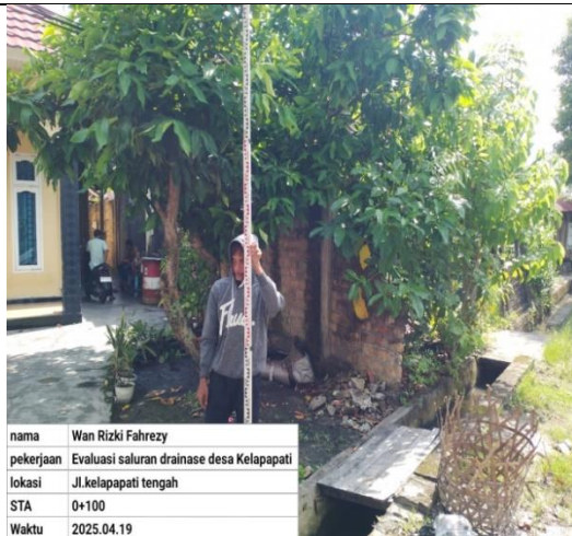
Survey Pengambilan Data Penampang Saluran STA 0+350
