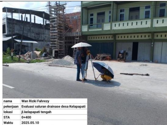
Survey Pengambilan Data Penampang Saluran STA 0+400
