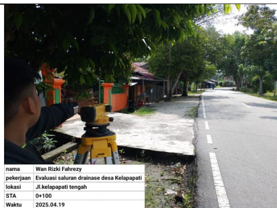
Survey Pengambilan Data Penampang Saluran STA 0+100
