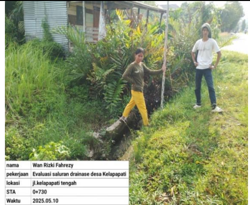
Survey Pengambilan Data Penampang Saluran STA 0+750
