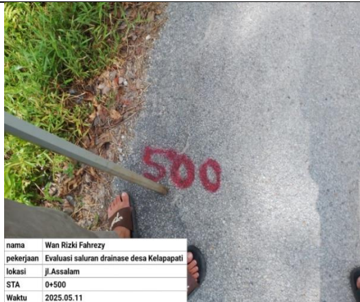
Survey Pengambilan Data Penampang Saluran STA 0+500
