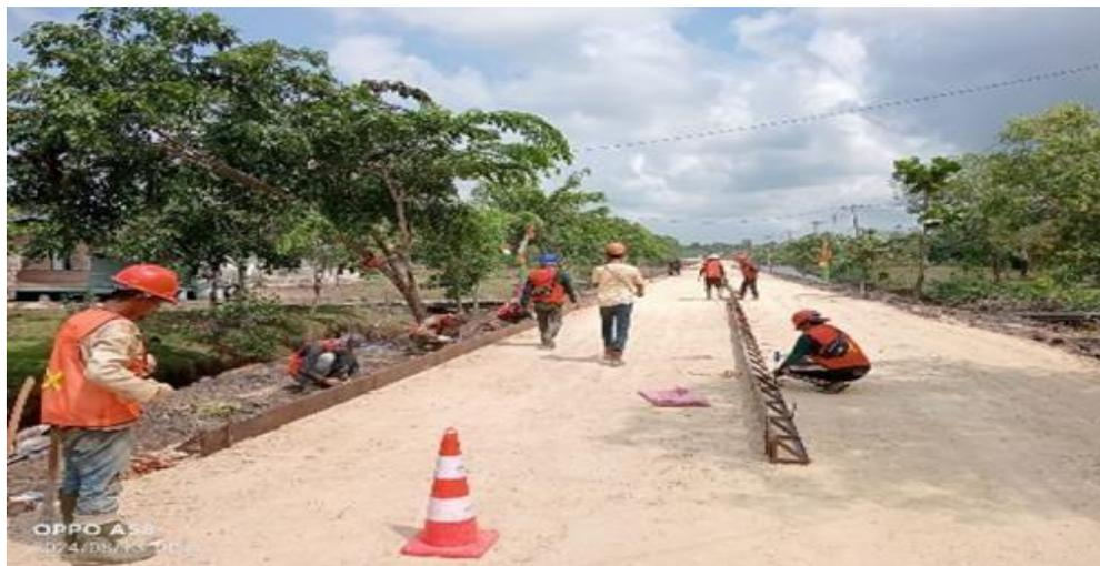
**Gambar 3. 15** Dokumentasi Pemasangan Mal Rigid
