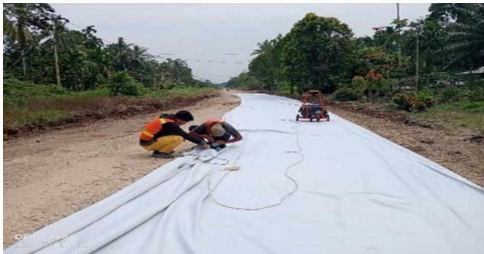
**Gambar 3. 10** Dokumentasi Pemasangan Geotex Woven
