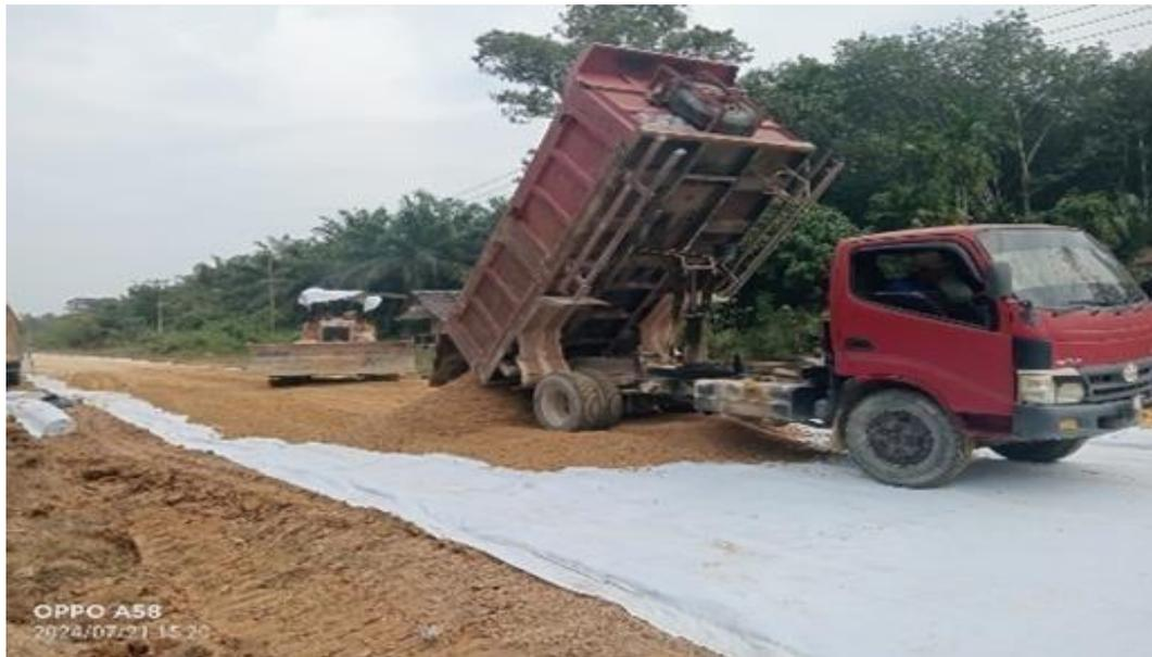
**Gambar 4. 2** Proses Penuangan Base B
