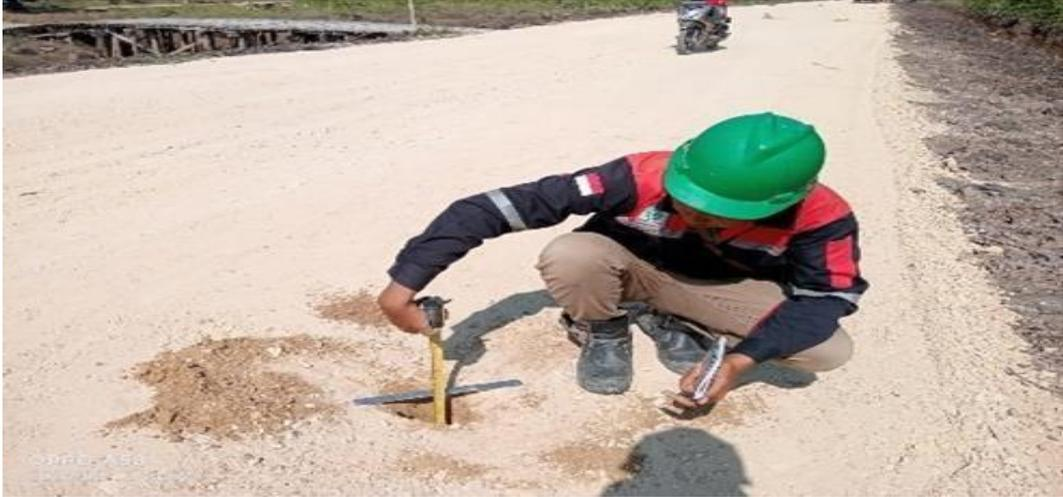
**Gambar 4. 6** Pengukuran Ketebalan Base B
