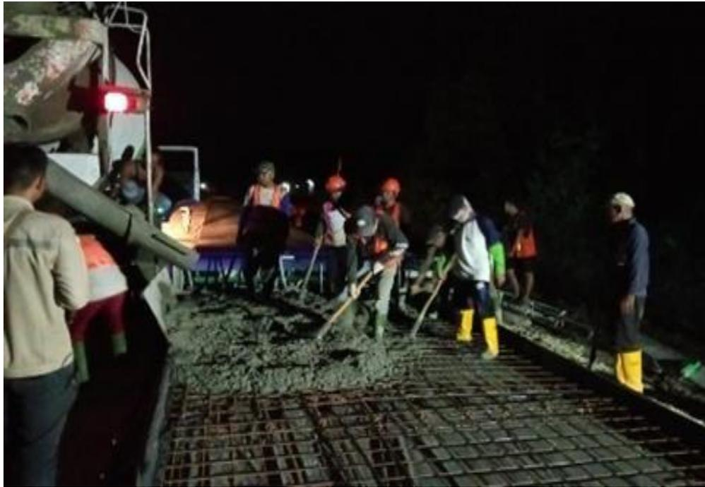
**Gambar 3. 16** Dokumentasi Pengecoran Rigid
