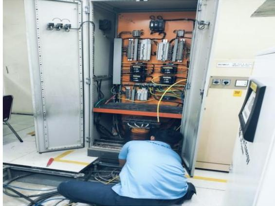
*Gambar 2. 4 Pemasangan Grounding*
