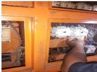
**Gambar 3.32 Pemasangan rangkaian star delta manual pada *electric pump***
