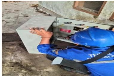
**Gambar 3.29 Perakitan rangkaian star delta pada *bale station***
