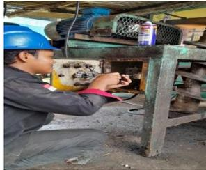
**Gambar 3.39 Pemasangan rangkaian DOL**
