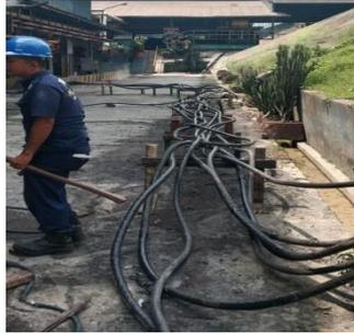
**Gambar 3. 105 Pembuatan penyanggah kabel 380 V**
