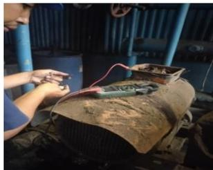
**Gambar 3.33 Penggantian kabel penghantar elektro motor 3 phasa**
