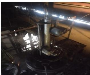
**Gambar 3.41 Penggantian pelampung moderator *control level* air**
