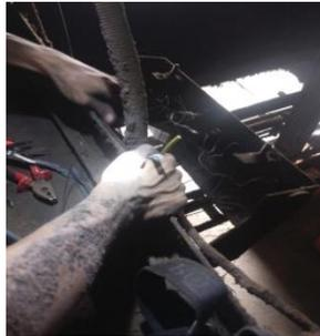
**Gambar 3.52 Pemasangan lampu *indicator press***
