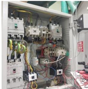
**Gambar 3.85 Pemasangan rangkaian kontrol star delta**
