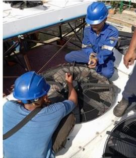
**Gambar 3.115 Perbaikan kipas *fan cooler***
