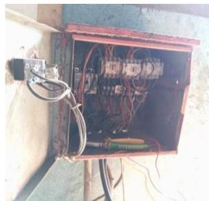
**Gambar 3.109 Pemasangan kontrol bolak balik mesin roll**
