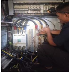
**Gambar 3.103** *Change Connect input elektro motor ke PLN*
