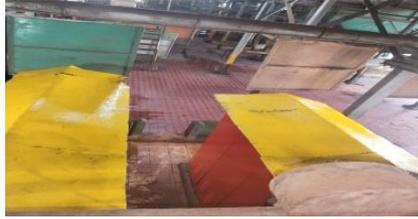
**Gambar 3.9** Pengecetan atap panel pada *Kernel station*
