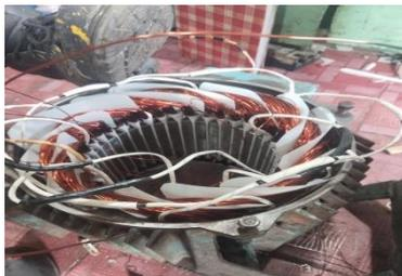
**Gambar 3.24** Pemasangan plastik prepsan pada elektro motor 3P
