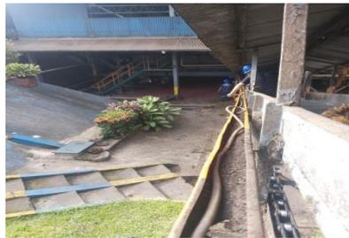
**Gambar 3.10** Pengecetan kebel *tray/jalur* pada *coveyor*
