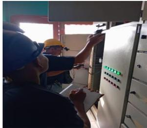
**Gambar 3.114 Pengecekan kapasitor bank**
