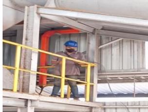
**Gambar 3.70 Pemasangan kabel *sliding***
