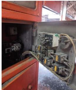
**Gambar 3.21 Perbaikan kabel CT (*Current Transformer*)**
