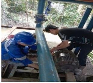
**Gambar 3.100 Pemasangan elektro motor pompa air waduk**
