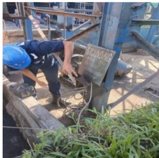
**Gambar 3.104** *Pengukuran tahanan grounding transformator*
