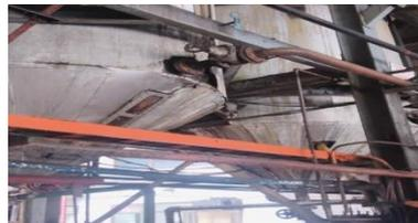
**Gambar 3.11** Pengecetan kebel *tray/jalur* elektro motor pada *clarification station*
