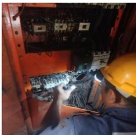
**Gambar 3.50 Pemasangan rangkaian kontrol *interlock***
