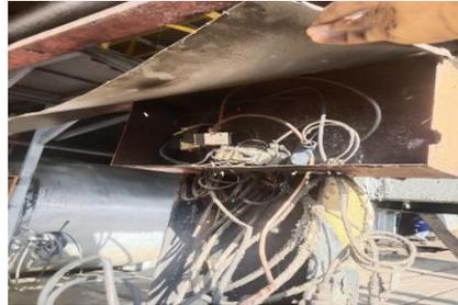
**Gambar 3.12 Penggantian pipa *velve solenoid condensat* pada panel kompresor**
