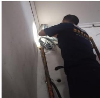
**Gambar 3.97 Penggantian kabel LAN CCTV**
