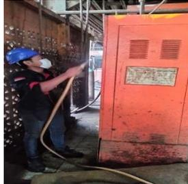
**Gambar 3.34 Cleaning panel pada boiler station**
