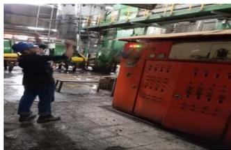
**Gambar 3.58 *Cleaning* panel listrik & elektro motor 3P**
