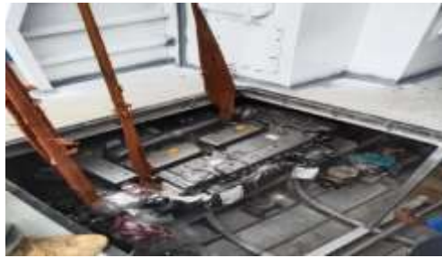
Gambar 2.4. 5 melihat proses penurunan dan pengepasan mesin pada kapal
