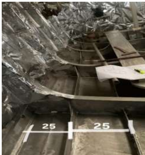
Gambar 2.3. 6 Pengukuran stiffener pada ruangan engine room
