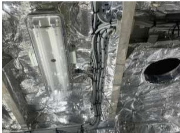
Gambar 2.6. 5 proses pemasangan instalasi kelistrikan
