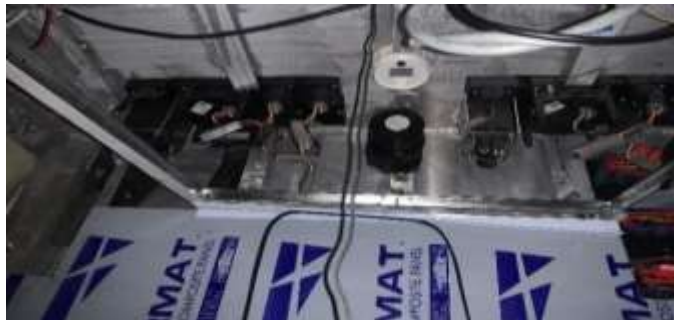
Gambar 2.5. 3 Melihat proses pemasangan instalasi kelistrika pada kapal
