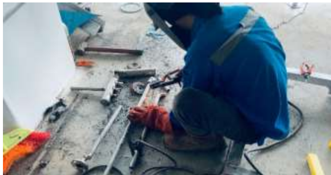
Gambar 2.6. 2 melihat proses pembuatan piping minyak
