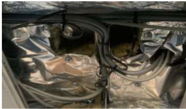
Gambar 2.6. 3 melihat proses pemasangan instalasi
