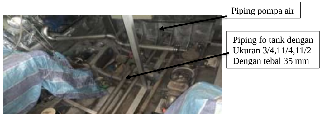
Gambar 2.6. 1 melihat proses pemasangan piping di ruangan engine room
