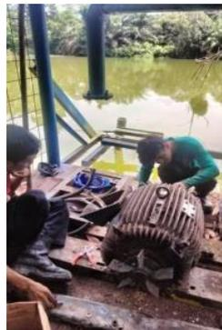
**Gambar 3. 57 Pemasangan elmot pompa waduk**
