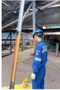
**Gambar 3. 24 Pengecatan tiang konveor inklinik**
