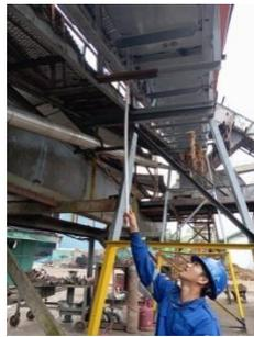
**Gambar 3. 25 Pengecatan tiang k0onveor inklinik**
