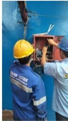
**Gambar 3. 37 Pemasangan arduino**
