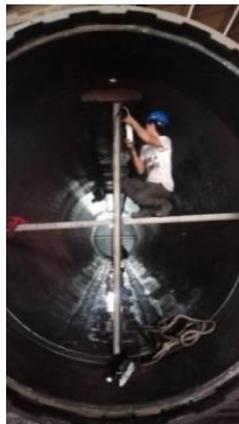
**Gambar 3. 39 Pemasangan instalasi lampu loading remm**
