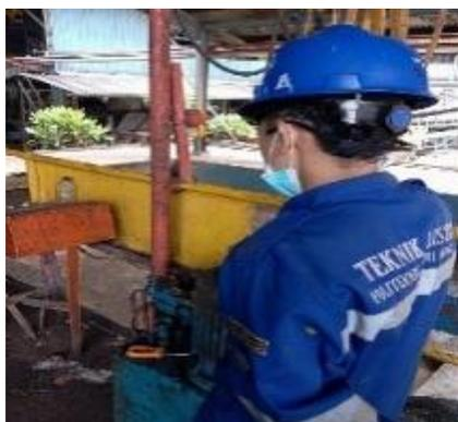
**Gambar 3.16 Perbaikan Panel Kontrol *Loading Ream***
