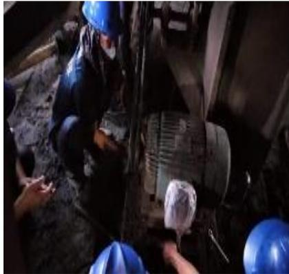
**Gambar 3.17 Penggantian Elektro Motor *Second Dary***
