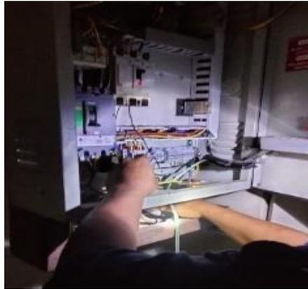
**Gambar 3.24 Perakitan Panel *Star Delta* Otomatis Pada *Bale Station***
