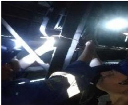
**Gambar 3.28 Pemasangan Lampu Sorot**
