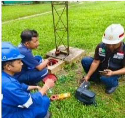
**Gambar 3.15 Pengukuran Nilai *Grounding* Wifi**
