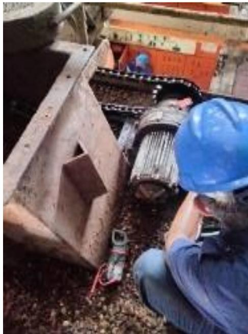
**Gambar 3.54 Pemasangan Elektro Motor *Elevator***
