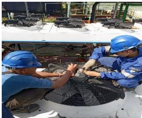
**Gambar 3.85 Pembongkaran Kipas/*Fan* Kondesor Pada Biogas**
