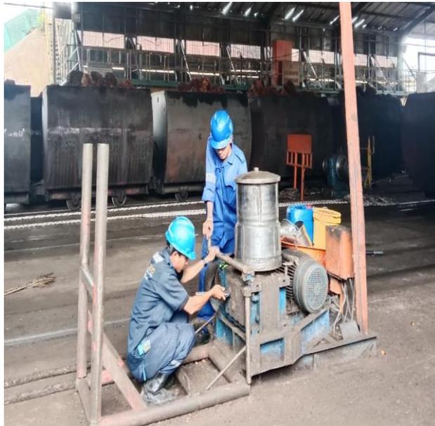
**Gambar 4.15 Pemberian Pelumas/*Greasing* Pada elektro Motor *Capstand***
