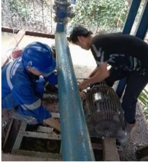
**Gambar 3.74 Pemasangan Elektro Motor Pompa Rawater Disungai**
