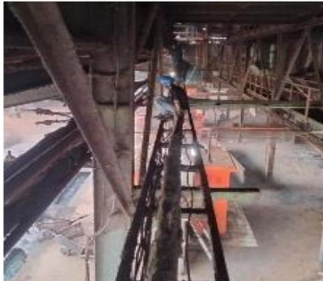
**Gambar 3.42 Pemasangan Kabel & Lampu *Indicator Press***
