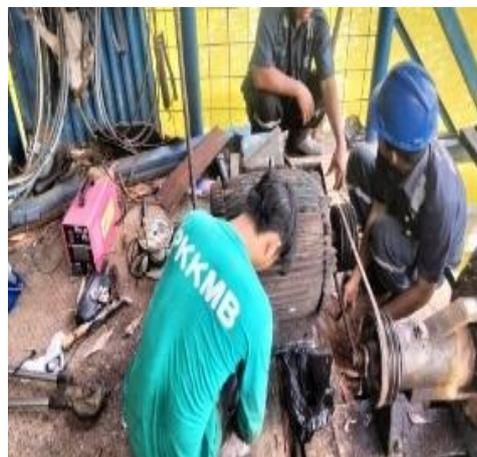
**Gambar 3.67 Pemasangan Elektro Motor Pompa *Rawater* Waduk**
