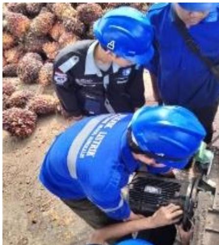
**Gambar 3.36 Pemasangan Elektro Motor Meja *Grading***
