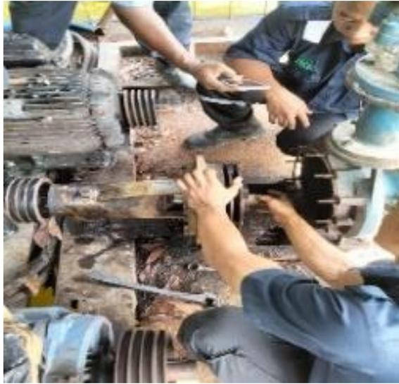
**Gambar 3.80 Perbaikan Pompa Waduk/*Pump Rawater***
