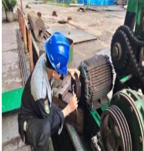
**Gambar 3.38 Pemasangan Elektro Motor Roll Plat Besi**
