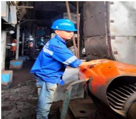
**Gambar 3.4 Perawatan Elektro Motor**
