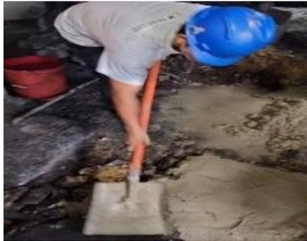
**Gambar 3.30 Pengecoran Lantai Jalur Kabel**
