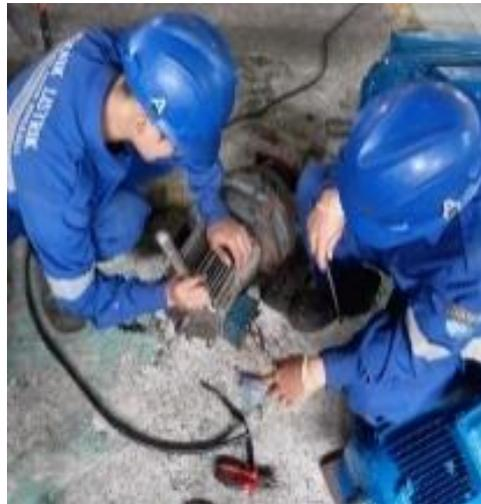
**Gambar 3.40 Pemasangan Seal Luar & Seal Dalam**
