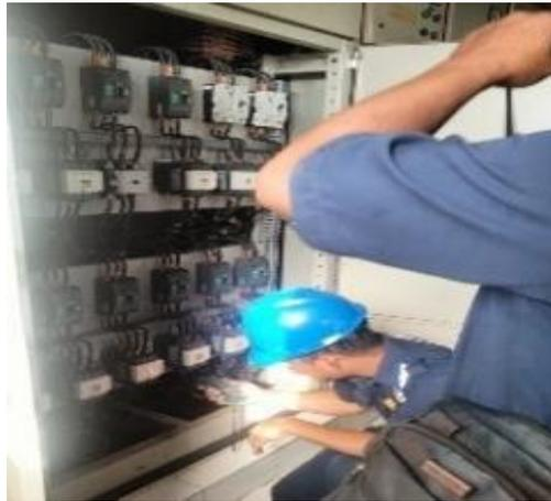
**Gambar 3.84 Pengecekan Arus & Tegangan**
