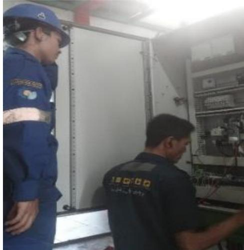
**Gambar 3.55 Pemasangan Kontaktor Pompa Heater G.E**
