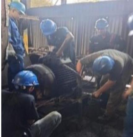
**Gambar 3.33 Pemasangan Elektro Motor ID Fan**
