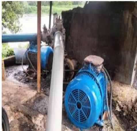
**Gambar 3.56 Pemasangan Penutup & Pengecatan Pompa Sirkulasi**
