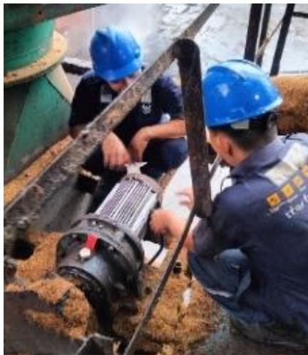
**Gambar 3.10 Pemasangan Elektro Motor Airlock Fibre Cyclone**
