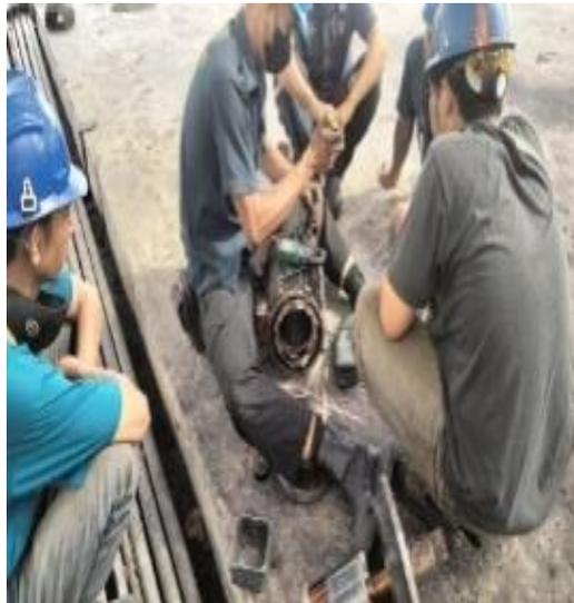
**Gambar 3.76 Pemasangan Elektro Motor *Conveyor* Pembuangan Abu Boiler**
