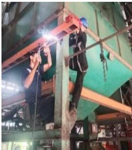
**Gambar 3.39 Perbaikan Jalur Kabel Tray**
