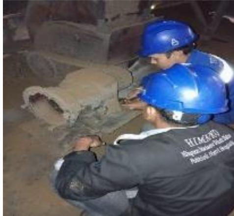
**Gambar 3.52 Pembongkaran Gearbox Pada Boiler Station**
