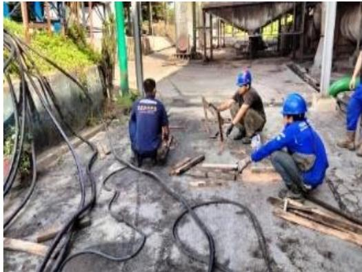
**Gambar 3.77 Pembuatn Lompat Gawang Untuk Kabel**
