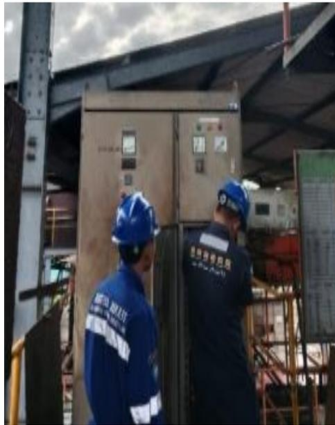
**Gambar 3.7 Pemasangan MCCB Pada *Bunch Press***
