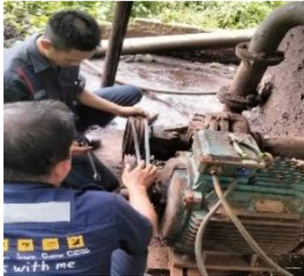
**Gambar 3.49 Perbaikan *Pully* Elektro Motor Pompa Sirkulasi**
