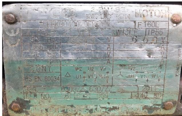
**Gambar 4.10 Name Plat Elektro Motor Capstand**
