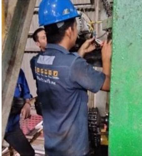
**Gambar 3.35 Pemasangan Elektro Motor *Airlock Fibre Cyclone***
