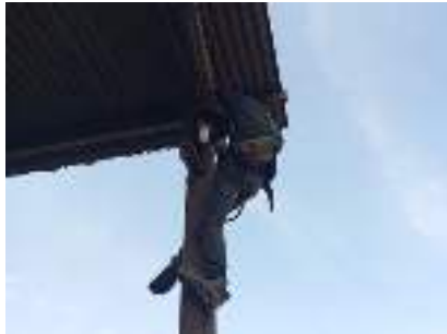
Gambar 3. 14 Pemasangan lampu (Sumber : Dokumentasi 2025)
