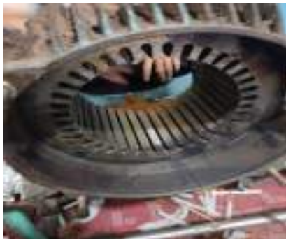
Gambar 3. 7 Membongkar elektro motor (Sumber : Dokumentasi 2025)
