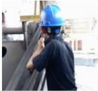
Gambar 3. 42 Pemasangan email drat elektro motor (Sumber : Dokumentasi 2025)
