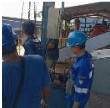
Gambar 3. 88 Perbaikan panel (Sumber : Dokumentasi 2025)
