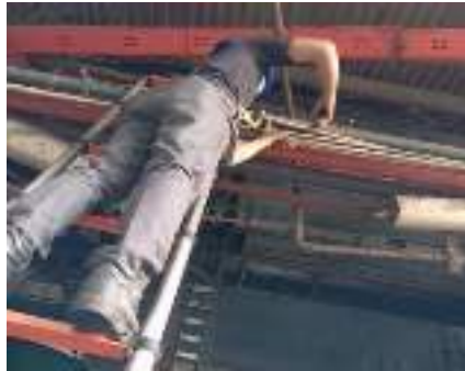
Gambar 3. 8 Merapikan kabel (Sumber : Dokumentasi 2025)
