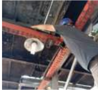
Gambar 3. 99 Merapikan kabel (Sumber : Dokumentasi 2025)
