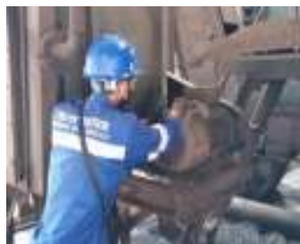
Gambar 3. 64 Cleaning elektro motor (Sumber : Dokumentasi 2025)
