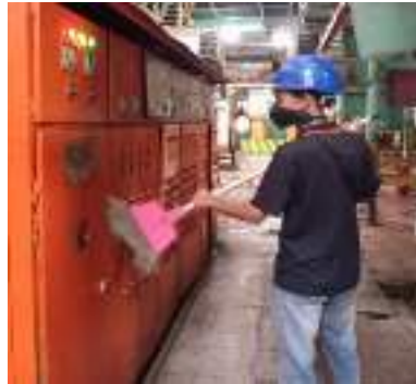
Gambar 3. 101 Cleaning panel (Sumber : Dokumentasi 2025)
