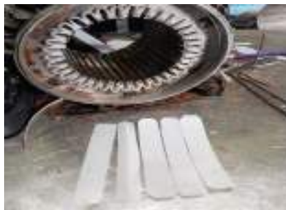
Gambar 3. 15 Pemasangan prespan (Sumber : Dokumentasi 2025)
