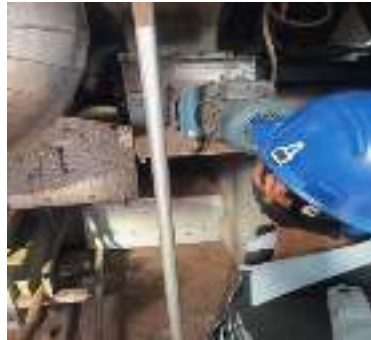
Gambar 3. 87 Cleaning elektro motor (Sumber : Dokumentasi 2025)
