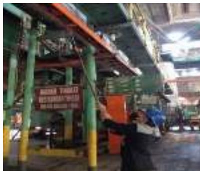
Gambar 3. 11 Mengecat try kabel kernel (Sumber : Dokumentasi 2025)
