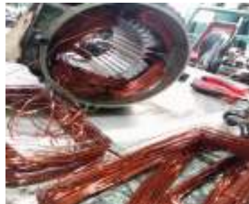
Gambar 3. 34 Pemasangan email drat elektro motor (Sumber : Dokumentasi 2025)
