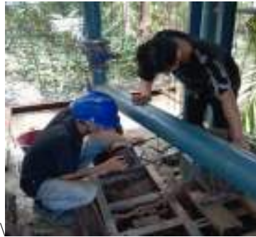
Gambar 3. 105 Pemasangan elektro motor (Sumber : Dokumentasi 2025)
