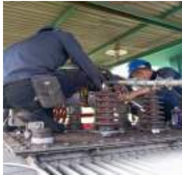
Gambar 3. 107 Pembersihan jaringan HUTM (Sumber : Dokumentasi 2025)
