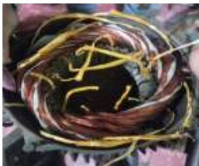
Gambar 3. 5 Membongkar elektro motor (Sumber : Dokumentasi 2025)
