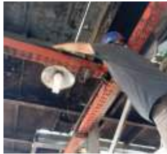
Gambar 3. 99 Merapikan kabel (Sumber : Dokumentasi 2025)
