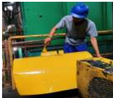
Gambar 3. 39 Pengecekan penutup elektro motor (Sumber : Dokumentasi 2025)
