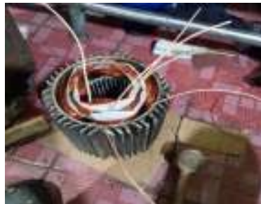
Gambar 3. 78 Pemasangan slongsong pada lilitan elektro motor (Sumber : Dokumentasi 2025)
