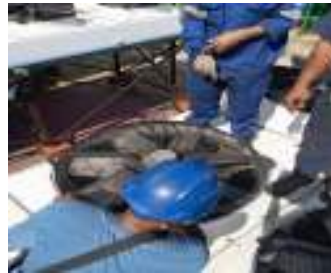
Gambar 3. 119 Perbaikan kipas (Sumber : Dokumentasi 2025)
