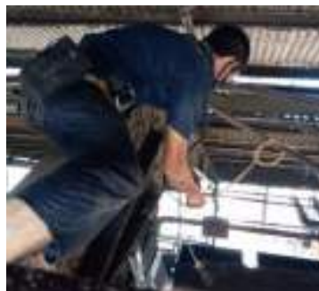
Gambar 3. 44 Pemasangan lampu sorot (Sumber : Dokumentasi 2025)
