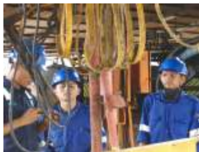
Gambar 3. 18 Perbaikan kabel transfer carriage (Sumber : Dokumentasi 2025)
