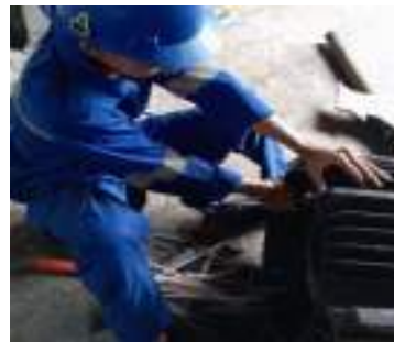
Gambar 3. 48 Melepaskan elektro motor (Sumber : Dokumentasi 2025)
