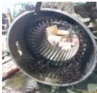
Gambar 3. 65 Membongkar elektro motor (Sumber : Dokumentasi 2025)
