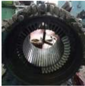
Gambar 3. 94 Pemasangan prespan ke jalur stator (Sumber : Dokumentasi 2025)
