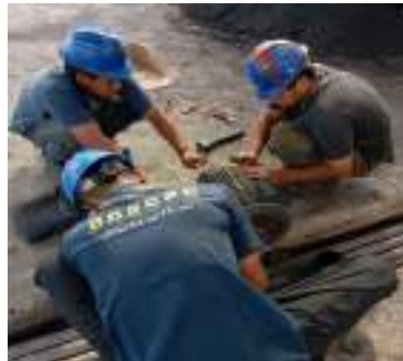
Gambar 3. 108 Perbaiki elektro motor (Sumber : Dokumentasi 2025)
