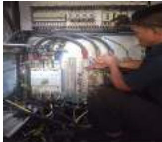
Gambar 3. 113 Memutus connect kabel (Sumber : Dokumentasi 2025)
