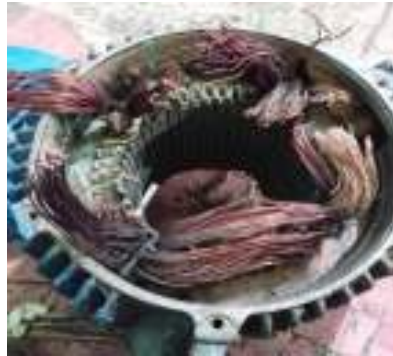
Gambar 3. 89 Membongkar elektro motor capstan (Sumber : Dokumentasi 2025)
