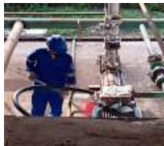
Gambar 3. 114 Cleaning elektro motor (Sumber : Dokumentasi 2025)
