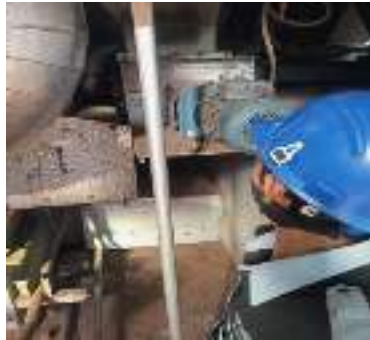
Gambar 3. 87 Cleaning elektro motor (Sumber : Dokumentasi 2025)
