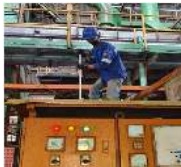
Gambar 3. 112 Cleaning panel (Sumber : Dokumentasi 2025)
