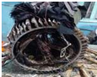
Gambar 3. 13 Membongkar elektro motor (Sumber : Dokumentasi 2025)
