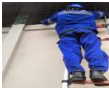
Gambar 3. 27 Pemasangan jalur kabel las (Sumber : Dokumentasi 2025)
