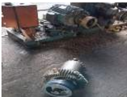
Gambar 3. 16 Mengganti rotor & pulley elektro motor (Sumber : Dokumentasi 2025)
