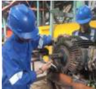
Gambar 3. 49 Mengganti bearing elektro motor (Sumber : Dokumentasi 2025)
