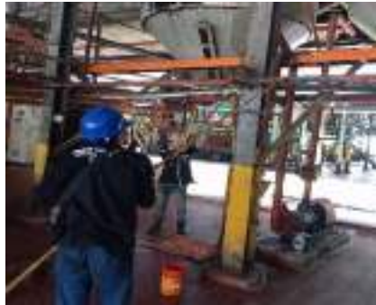
Gambar 3. 10 Pengecetan jalur kabel (Sumber : Dokumentasi 2025)
