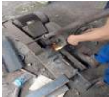
Gambar 3. 121 Pemotongan plat (Sumber : Dokumentasi 2025)
