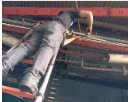
Gambar 3. 8 Merapikan kabel (Sumber : Dokumentasi 2025)
