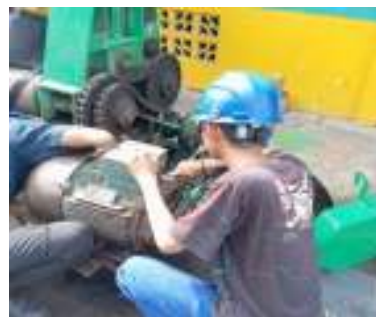
Gambar 3. 29 Pemasangan elektro motor (Sumber : Dokumentasi 2025)
