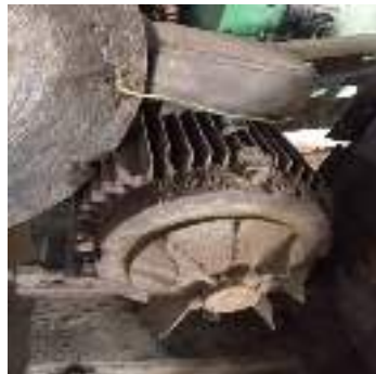
Gambar 3. 86 Cleaning elektro motor (Sumber : Dokumentasi 2025)
