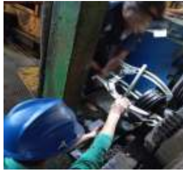
Gambar 3. 91 Mengganti pulley (Sumber : Dokumentasi 2025)
