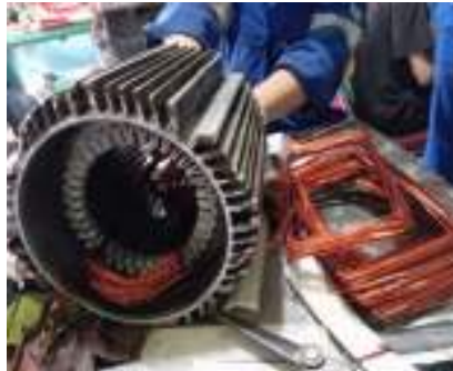
Gambar 3. 17 Pemasangan email drat elektro motor (Sumber : Dokumentasi 2025)
