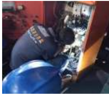
Gambar 3. 33 Penggantian kontaktor (Sumber : Dokumentasi 2025)
