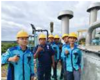
Gambar 3. 1 Pengenalan komponen pembangkit listrik (Sumber : Dokumentasi 2025)
