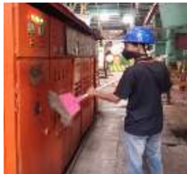
Gambar 3. 110 Cleaning panel (Sumber : Dokumentasi 2025)
