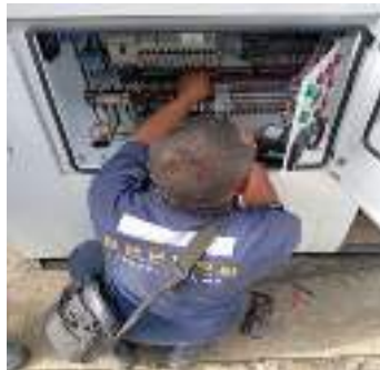
Gambar 3. 109 Perbaiki panel (Sumber : Dokumentasi 2025)
