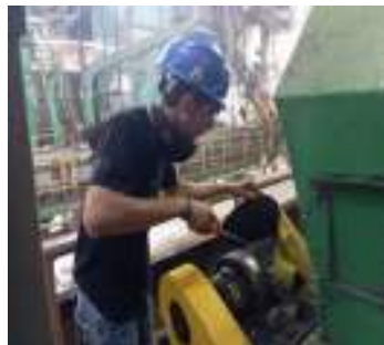
Gambar 3. 41 Pemasangan email drat elektro motor (Sumber : Dokumentasi 2025)
