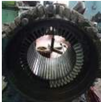
Gambar 3. 94 Pemasangan prespan ke jalur stator (Sumber : Dokumentasi 2025)
