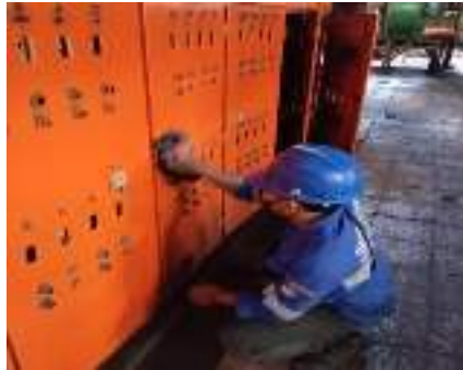
Gambar 3. 21 Perawatan panel (Sumber : Dokumentasi 2025)
