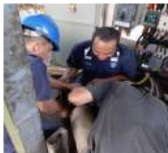
Gambar 3. 98 Mengkonekkan kabel (Sumber : Dokumentasi 2025)
