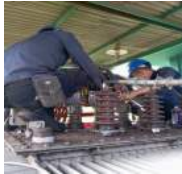
Gambar 3. 107 Pembersihan jaringan HUTM (Sumber : Dokumentasi 2025)
