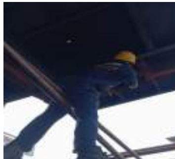
Gambar 3. 95 Pemasangan jalur kabel (Sumber : Dokumentasi 2025)
