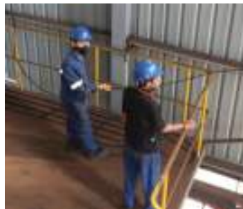
Gambar 3. 73 Pemasangan jalur kabel (Sumber : Dokumentasi 2025)
