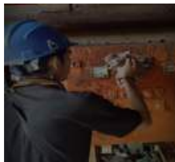
Gambar 3. 84 Cleaning panel (Sumber : Dokumentasi 2025)
