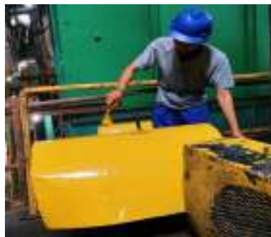
Gambar 3. 39 Pengecetan penutup elektro motor (Sumber : Dokumentasi 2025)
