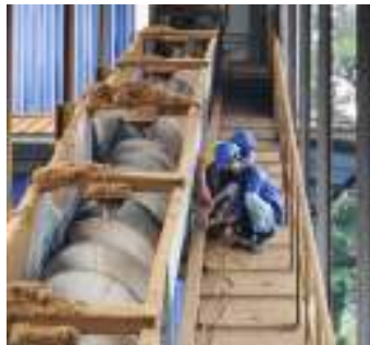
Gambar 3. 62 Merapikan try kabel conveyor (Sumber : Dokumentasi 2025)
