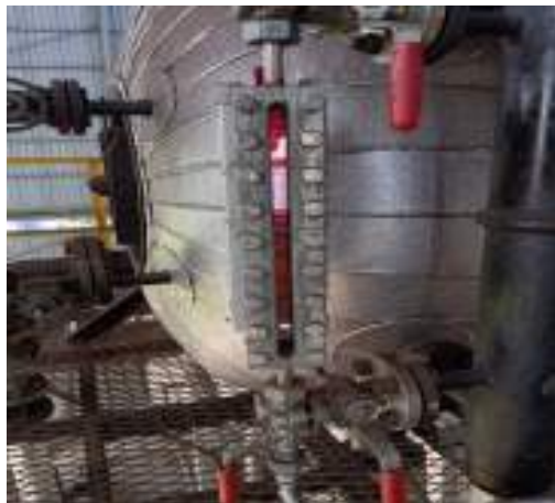
Gambar 4. 4 Gelas penduga (Sumber : Dokumentasi 2025)
