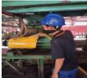
Gambar 3. 111 Cleaning elektro motor (Sumber : Dokumentasi 2025)
