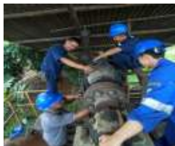
Gambar 3. 120 Pemasangan shell gearbox (Sumber : Dokumentasi 2025)
