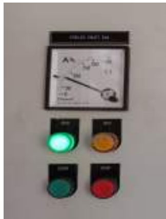
Gambar 4. 8 Pengukur ampere forced draught fan (Sumber : Dokumentasi 2025)
