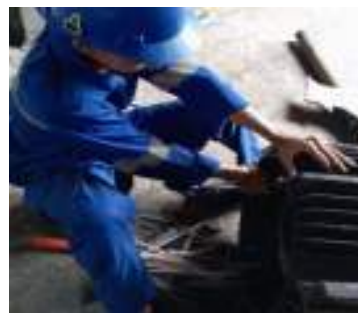
Gambar 3. 48 Melepaskan elektro motor (Sumber : Dokumentasi 2025)
