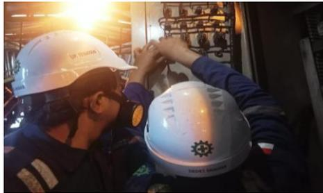
Gambar 3. 8 Izat penormalan jalur lampu yang short, penggantian lampu C04 area Coal Handling Control Building (CHCB).
