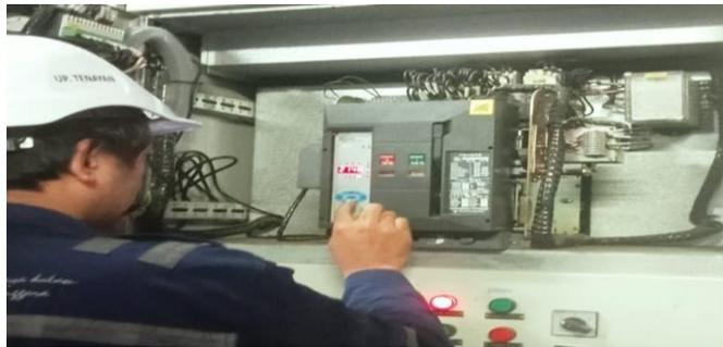
Gambar 3. 66 Pengecekan kontrol AVR unit 2
