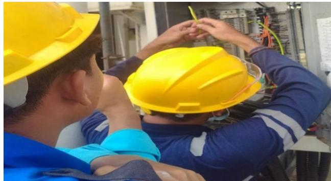
Gambar 3. 62 Perbaiki sistem Proteksi pada Main Transformer unit 2
