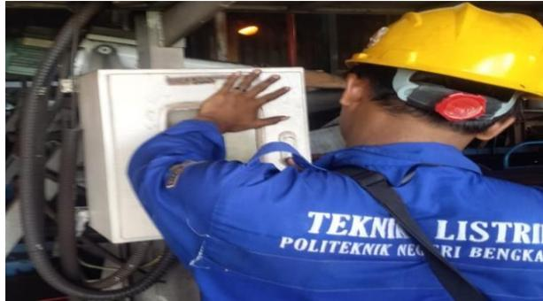
Gambar 3. 80 Perbaikan panel V-plough conveyor C04B
