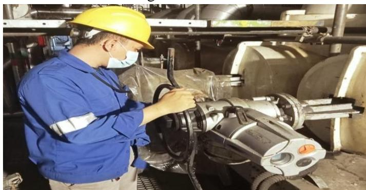
Gambar 3. 3 Perbaikan motor MOV di area Turbin
