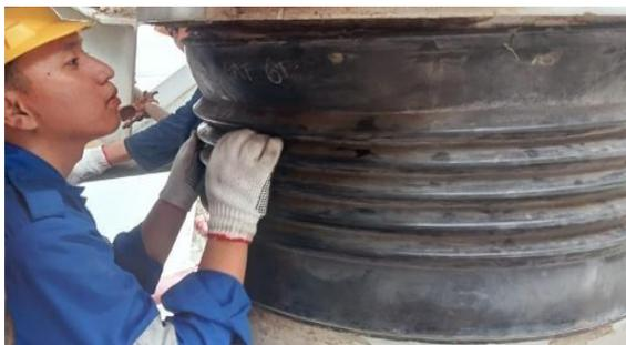
Gambar 3. 57 Perbaikan dan pembersihan terminal di main Transformator
