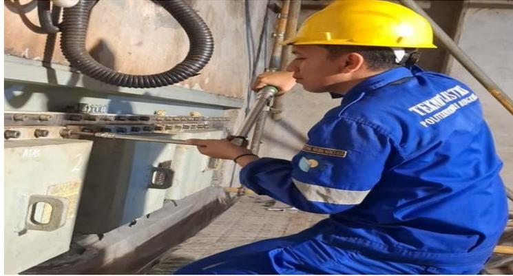
Gambar 3. 61 Momentum kekencangan baut Cooler Generator
