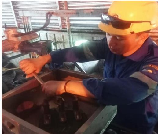
**Gambar 4. 26** Pemasangan cover box dan power motor
