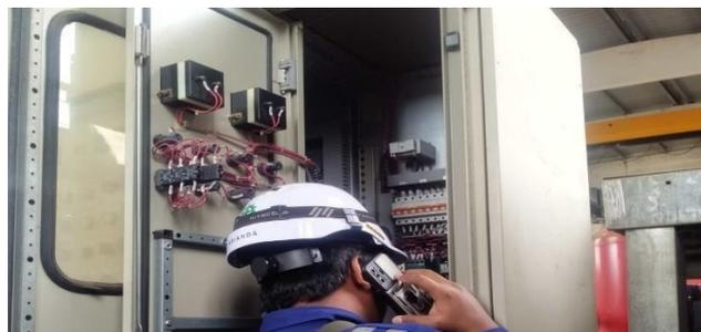
Gambar 3. 49 Pengecekan panel di gedung WWTP
