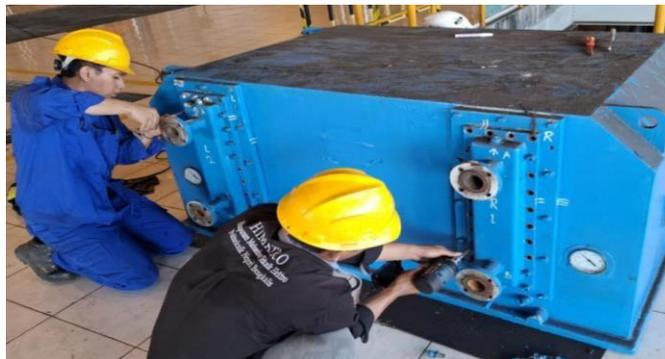
Gambar 3. 72 Pengecekan dan perbaikan *Cooler* motor Boiler Feed Pump 1B
