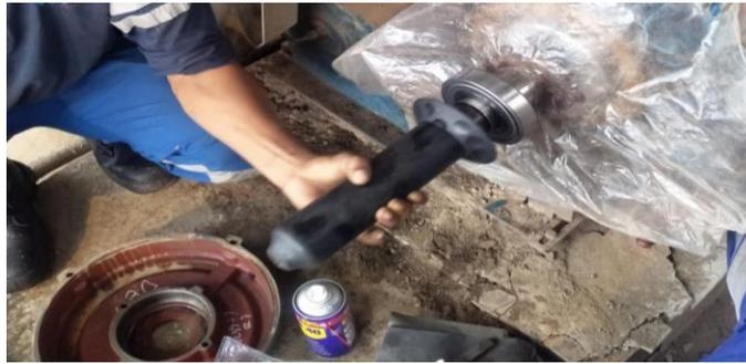
Gambar 3. 59 Penggantian bearing motor *root blower* A&B di PLTU Tenayan.
