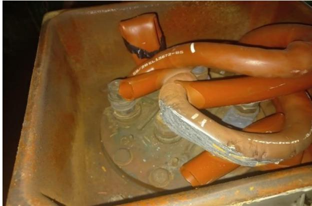
**Gambar 4. 22** Pengecekan visual kabel getas penyebab hot spot
