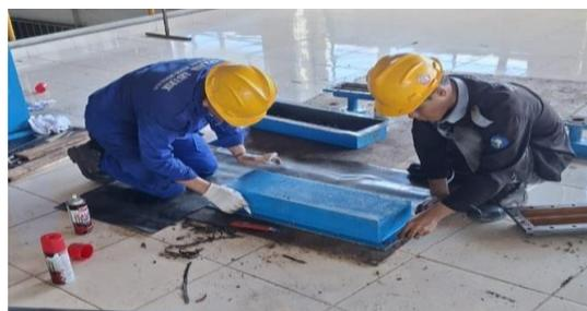
Gambar 3. 73 *Vaccum test cooler* motor BFP dan pembuatan paking
