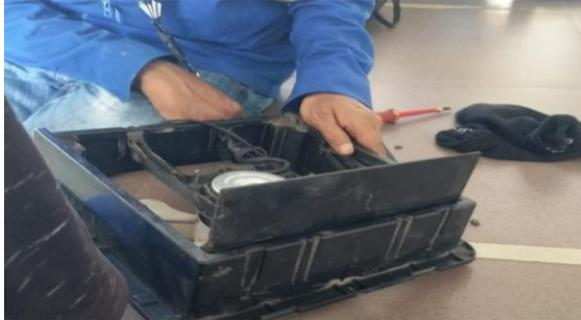
Gambar 3. 50 Pemasangan Fan Blower WC di Masjid
