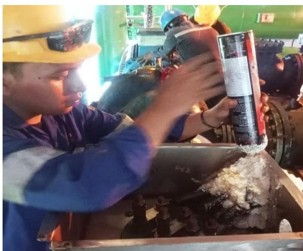
**Gambar 4. 29** Penyemprotan Foam Xtraseal
