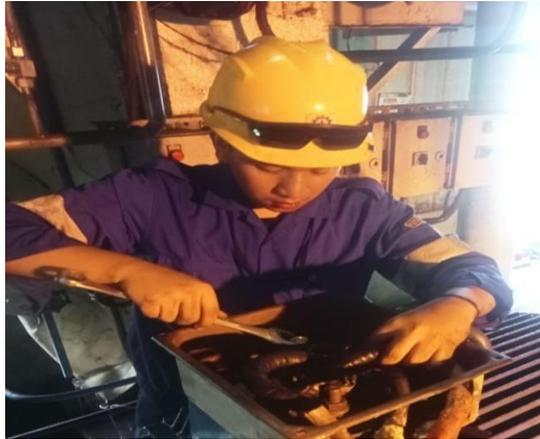
**Gambar 4. 24** Membuka sambungan power pada terminal
