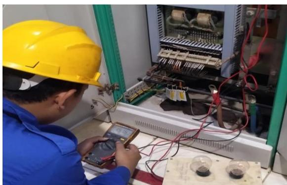
Gambar 3. 65 Pengukuran katoda dan anoda
