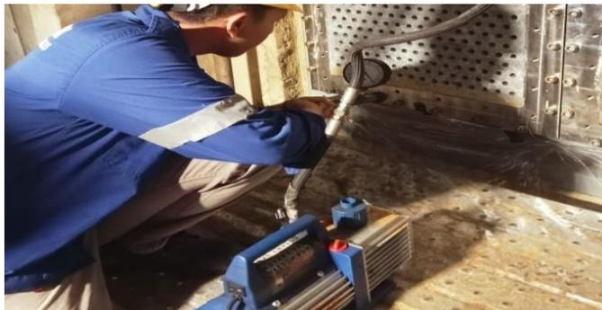
Gambar 3. 60 Pembersihan Cooler generator
