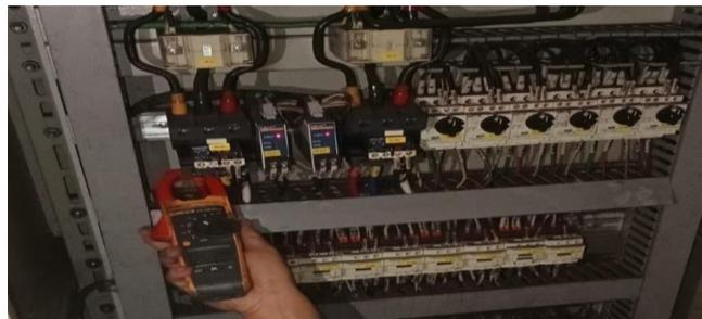
Gambar 3. 67 Pengecekan relay pada trafo UAT
