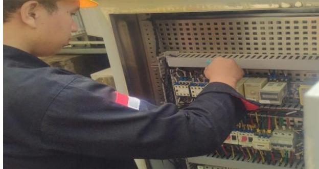
Gambar 3. 74 Pembersihan dan pengecekan Breker dan kabel breker pada area CHCB
