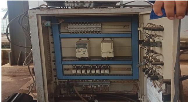
Gambar 3. 71 Perbaiki panel kontrol *viplact* pada *conveyor belt* 03
