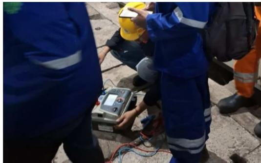
Gambar 3. 51 Megger breaker 6KV BFP 1C
