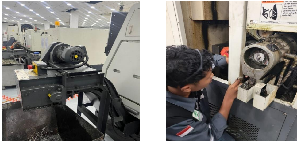
Gambar 3.13 Perbaikan Motor Conveyor
