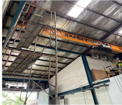
Gambar 3.4 Perbaikan Overheat Crane
