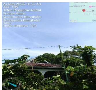
Gambar 3. 82 Pekerjaan memperbaiki Kabel JTR
