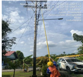
Gambar 3. 43 Pekerjaan mengganti Fuse Link FCO
