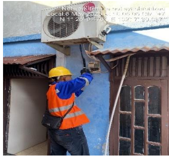
Gambar 3. 57 Pekerjaan mengganti MCB
