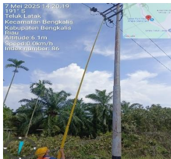
Gambar 3. 61 Pekerjaan mengganti Fuse Link FCO
