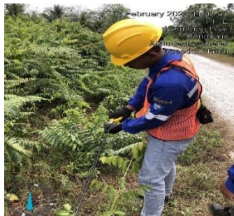
Gambar 3. 11 Pekerjaan penyambungan Kabel SR
