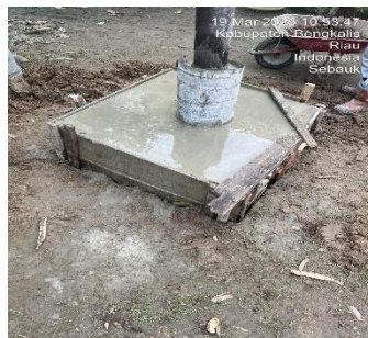
Gambar 3. 32 Pekerjaan Pengecoran Tiang TM
