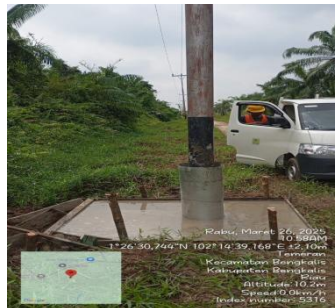
Gambar 3. 37 Pekerjaan mengecor Tiang TM
