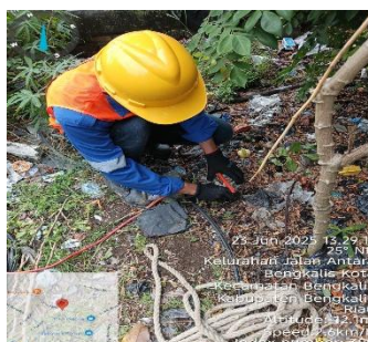
Gambar 2.98 Pekerjaan memasang Ground Cluster
