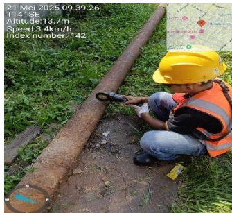
Gambar 3. 80 Pekerjaan memotong Tiang Kropos
