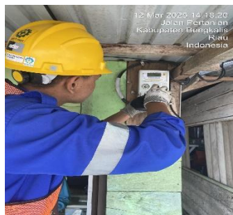
Gambar 3. 25 Pekerjaan pergantian KWH Meter
