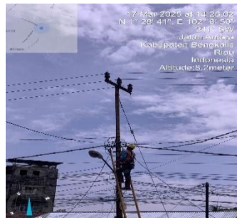
Gambar 3. 29 Perbaikan Lost Kontak Phasa
