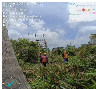
Gambar 3. 34 Pekerjaan pemasangan kawat seling
