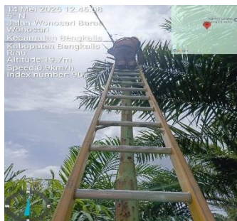
Gambar 3. 66 Pekerjaan memperbaiki Lost Kontak Fasa
