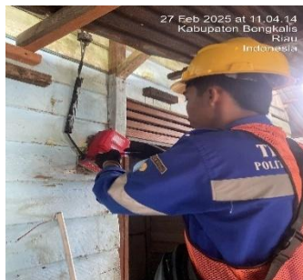
Gambar 3. 16 Pekerjaan pergantian MCB
