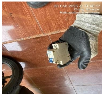
Gambar 3. 13 Pekerjaan pergantian MCB
