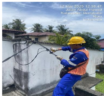
Gambar 3. 24 Pekerjaan perbaikan Lost Kontak Phasa
