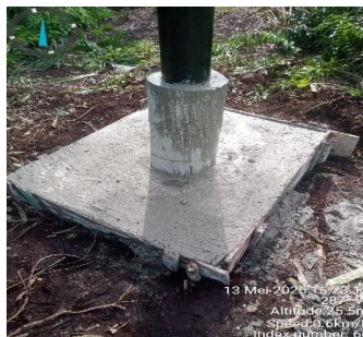
Gambar 3. 64 Pekerjaan mengecor Manset Tiang
