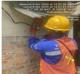
Gambar 3. 41 Pekerjaan mengganti KWH Meter
