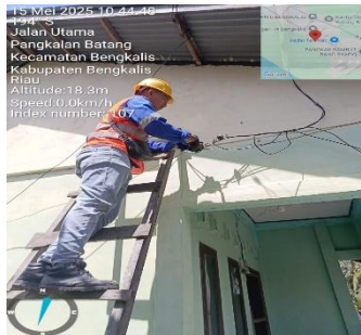
Gambar 3. 71 Pekerjaan memperbaiki Kabel SR
