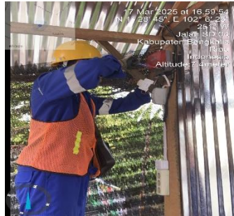
Gambar 3. 31 Pekerjaan pergantian KWH Meter
