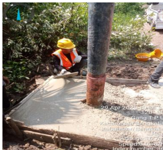
Gambar 3. 52 Pekerjaan mengecor Manset Tiang
