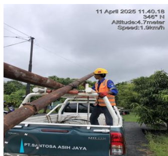
Gambar 3. 45 Pemindahan Tiang TR
