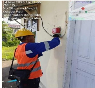
Gambar 3. 70 Pekerjaan mengganti kWh Meter
