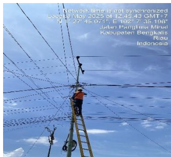
Gambar 3. 56 Pekerjaan memperbaiki Lost Kontak Phasa
