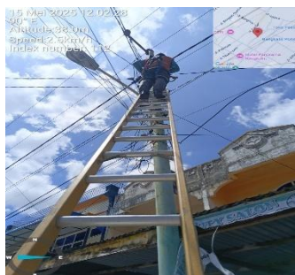
Gambar 2.72 Pekerjaan memperbaiki Lost Kontak Phasa
