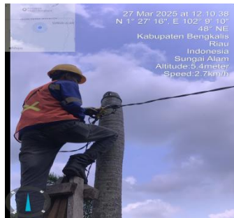
Gambar 3. 38 Pekerjaan memperbaiki Lost Kontak Phasa
