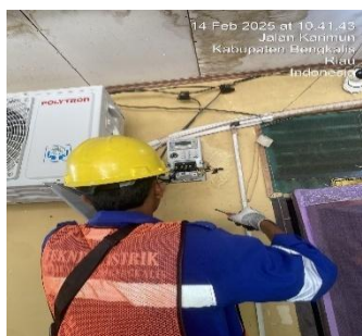
Gambar 3. 7 Pekerjaan Pergantian KWH Meter
