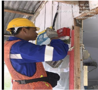
Gambar 3. 10 Pekerjaan Pergantian KWH Meter
