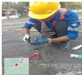
Gambar 3. 35 Pekerjaan mengganti Fuse Link
