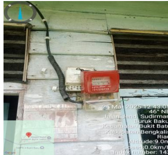
Gambar 3. 36 Pekerjaan mengganti KWH Meter
