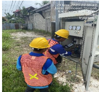
Gambar 3. 33 Pengukuran Tegangan
