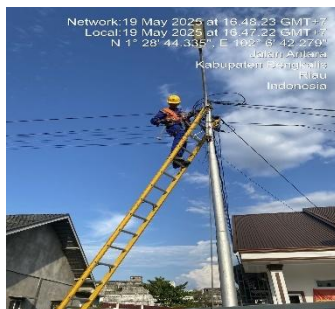
Gambar 3. 78 Pekerjaan memperbaiki Kabel SR
