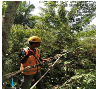
Gambar 3. 44 Pekerjaan meluruskan Tiang TR
