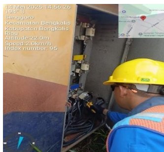
Gambar 3. 69 Pekerjaan mengganti NH Fuse
