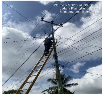
Gambar 3. 15 Pekerjaan penyambungan Kabel SR
