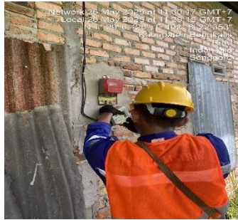
Gambar 3. 85 Pekerjaan mengganti kWh Meter
