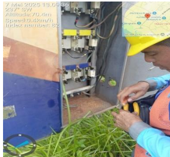
Gambar 3. 60 Pekerjaan mengganti NH Fuse
