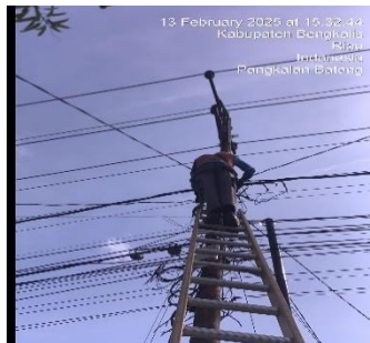
Gambar 3. 5 Perbaikan Lost Kontak
