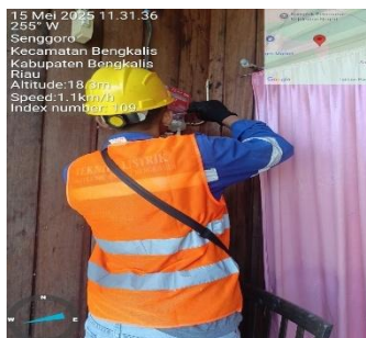
Gambar 3. 72 Pekerjaan mengganti kWh Meter
