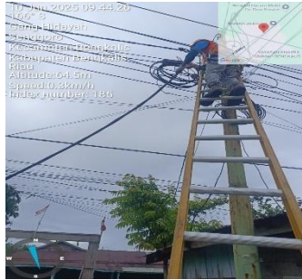
Gambar 3. 95 Pekerjaan mengganti Kabel JTR
