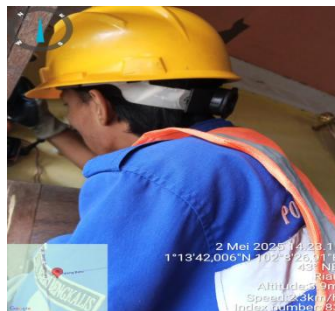
Gambar 3. 54 Pekerjaan mengganti MCB
