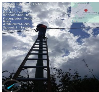
Gambar 3. 84 Pekerjaan memperbaiki Lost Kontak Phasa
