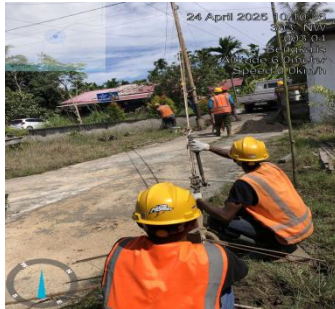
Gambar 3. 50 Pekerjaan meluruskan Tiang
