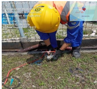
Gambar 3. 77 Pekerjaan pemasangan Ground Cluster
