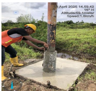
Gambar 3. 49 Pekerjaan mengecor Tiang TM
