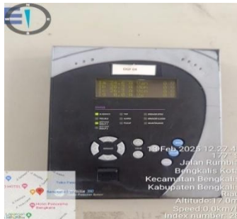
Gambar 3. 4 Pengecekan Beban Feeder
