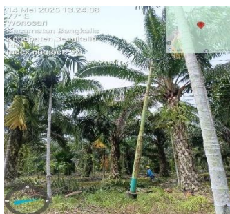
Gambar 3. 67 Pekerjaan meluruskan Tiang JTR
