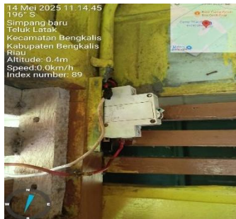
Gambar 3. 65 Pekerjaan mengganti MCB
