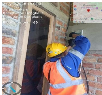
Gambar 3. 86 Pekerjaan memindahkan kWh Meter
