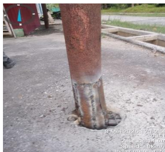
Gambar 3. 62 Pekerjaan Las Tiang TM
