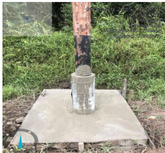
Gambar 3. 39 Pekerjaan mengecor Tiang TM
