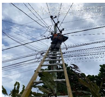
Gambar 3. 59 Pekerjaan memperbaiki Lost Kontak Phasa
