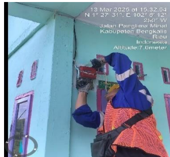
Gambar 3. 26 Pekerjaan pergantian KWH Meter
