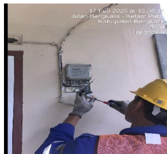
Gambar 3. 9 Pekerjaan pergantian MCB
