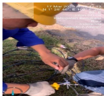
Gambar 3. 30 Pekerjaan Penyambungan SR
