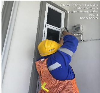
Gambar 3. 21 Pekerjaan pergantian MCB
