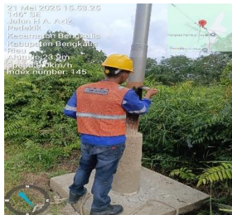
Gambar 3. 81 Pekerjaan mengecat Tiang JTR
