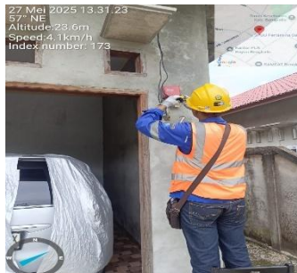
Gambar 3. 89 Pekerjaan mengganti kWh Meter
