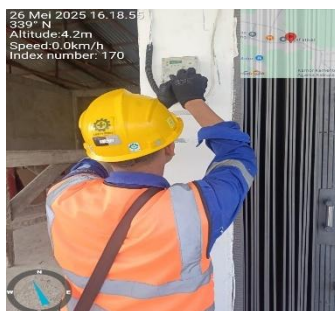
Gambar 3. 87 Pekerjaan memperbaiki Baut kWh Meter
