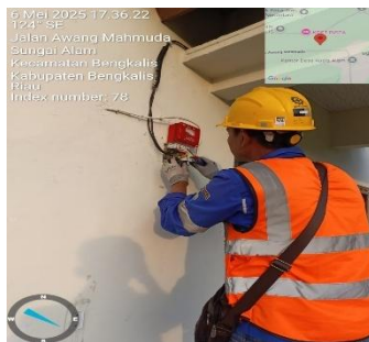
Gambar 3. 58 Pekerjaan mengganti MCB
