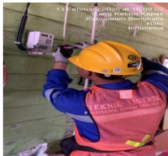
Gambar 3. 6 Pekerjaan Pergantian KWH Meter
