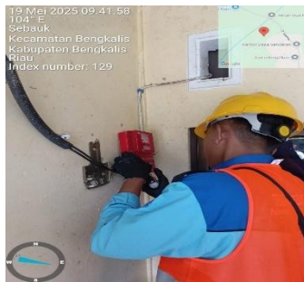
Gambar 3. 75 Pekerjaan memperbaiki kWh Meter
