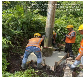
Gambar 3. 53 Pekerjaan mengecor Manset Tiang
