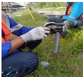
Gambar 3. 90 Pekerjaan mengganti Fuse Link FCO
