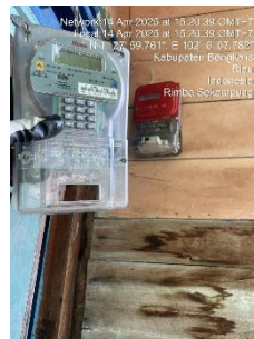
Gambar 3.1.4 Penggantian kwh meter
