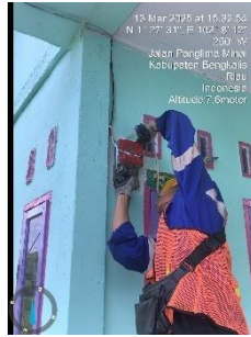
Gambar 3.1.3 Penggantian kwh meter
