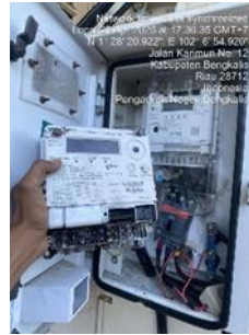
Gambar 3.1.4 Penggantian kwh meter 3pas
