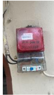
Gambar 3.1.5 Penggantian kwh meter
