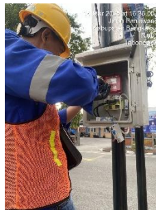
Gambar 3.1.3 Penggantian kwh meter
