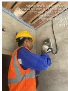
Gambar 3.1.4 Penggantian kwh meter
