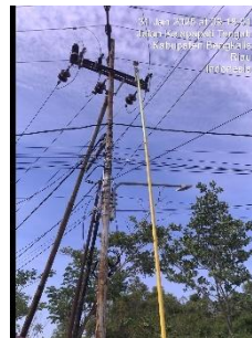
Gambar 3.1.1 Perbaikan fco yang putus dan pemasangan fco
