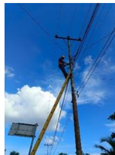
Gambar 3.1.4 Memperbaiki kabel sr
