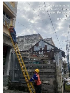
Gambar 3.1.1 Pengecekan kabel sr
