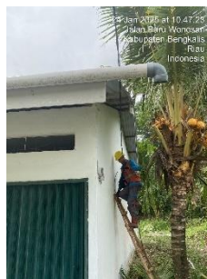
Gambar 3.1.1 Pemasangan kabel sr
