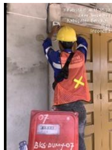
Gambar 3.1.2 Penggantian meter sementara
