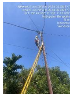
Gambar 3.1.6 Perbaikan percing
