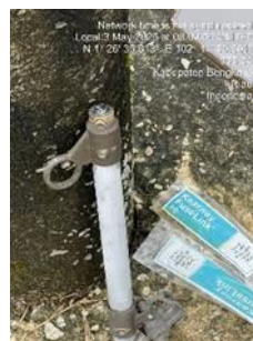
Gambar 3.1.5 Penggantian fuselink
