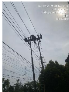
Gambar 3.1.2 Pemasangan pin isolator penyulang tegal
