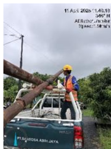
Gambar 3.1.4 Pemindahan tiang jtr
