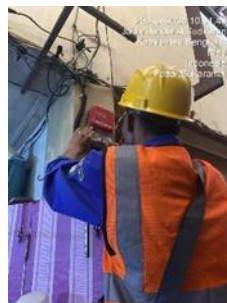
Gambar 3.1.4 Penggantian kwh meter
