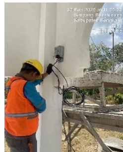
Gambar 3.1.2 Pemindahan kwh meter
