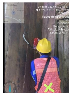
Gambar 3.1.3 Penggantian kwh meter
