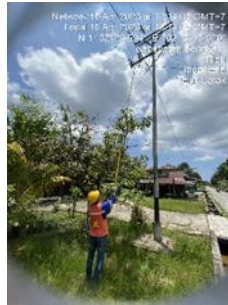
Gambar 3.1.4 Penggantian fuselink
