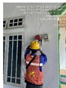
Gambar 3.1.4 Penghentian mcb
