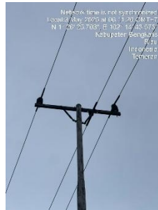
Gambar 3.1.5 Memperbaiki pin isolator
