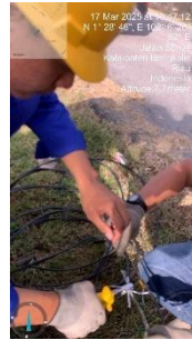
Gambar 3.1.3 Penyambungan kabel
