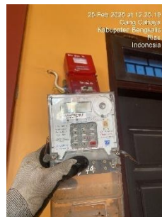
Gambar 3.1.2 Penggantian meteran
