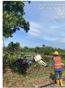
Gambar 3.1.1 Perbaikan tiang tm tumbang
