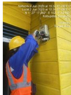
Gambar 3.1.6 Penggantian kwh meter
