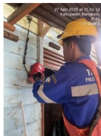
Gambar 3.1.2 Penggantian kwh meter
