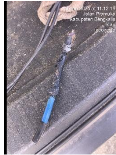
Gambar 3.1.1 Perbaikan kabel sku
