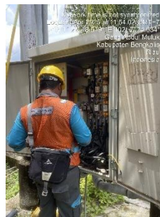
Gambar 3.1.4 Memperbaiki dudukan nh
