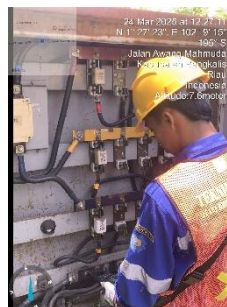
Gambar 3.1.3 Pengecekan tegangan pada trafo
