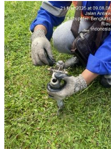
Gambar 3.1.3 Penggantian fuselink
