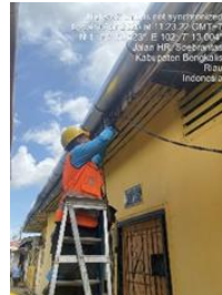
Gambar 3.1.4 Penggantian kabel sr
