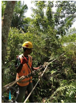
Gambar 2.63 Proses meluruskan tiang TR
