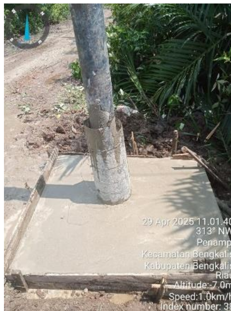
Gambar 2.81 Pengecoran manset
