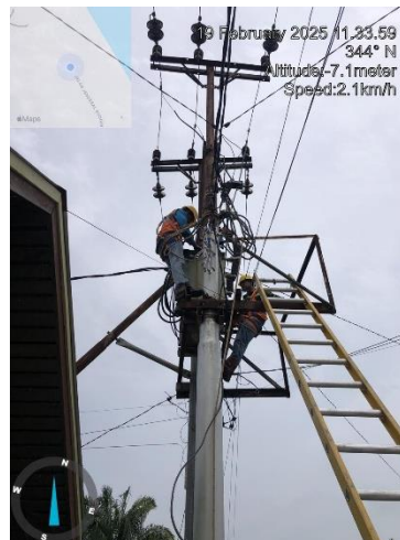
Gambar 2.51 Pemeliharaan PHBTR
