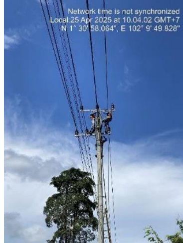
Gambar 2.78 Penyambungan kabel TM
