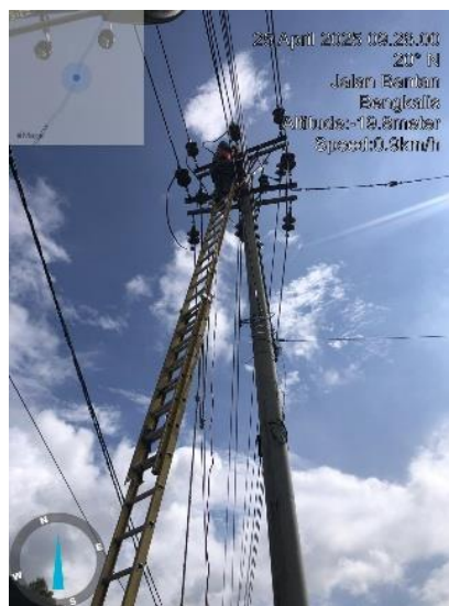
Gambar 2.77 Pemasangan groundcluster
