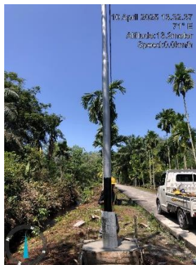
Gambar 2.64 pengecatan tiang TR
