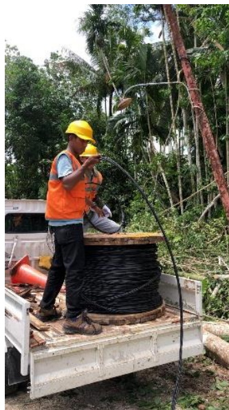
Gambar 2.71 Pemasangan kabel SKUTR
