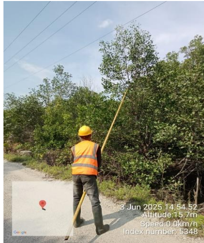
Gambar 2.22 Pemasangan hendel 1phasa
