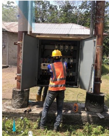
Gambar 2.31 Pembersihan box panel/lasbor
