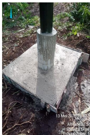
Gambar 2.92 Pengecoran manset
