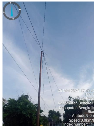
Gambar 2.104 Pemasangan SR pelanggan
