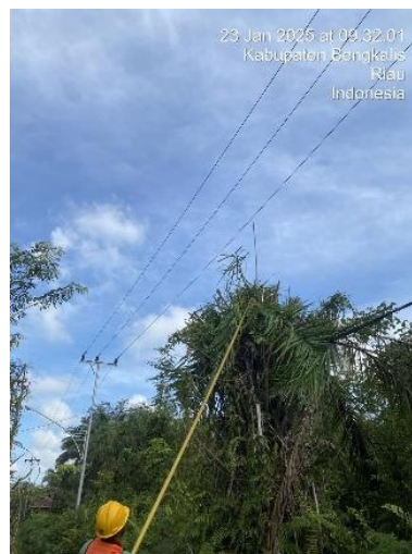
Gambar 2.11 Pemangkasan/ROW
