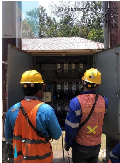
Gambar 2.38 Pengecekan tegangan setelah di PHB-TR
