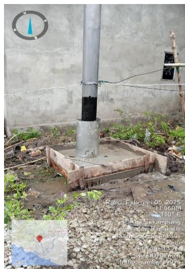
Gambar 2.19 Pengecoran manset
