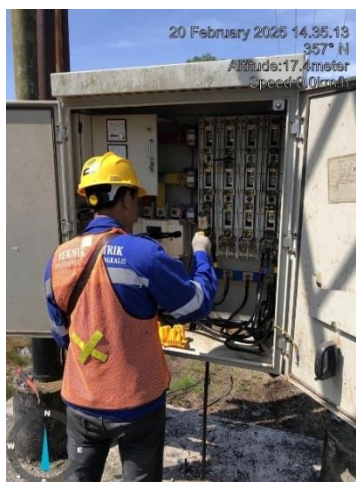
Gambar 2.36 Pemberian gris pada nh fuse dan pemmasangan nh fuse
