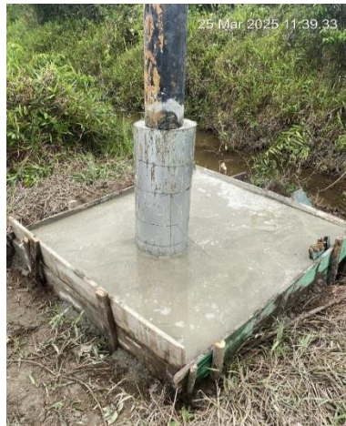
Gambar 2.56 Pengecoran manset
