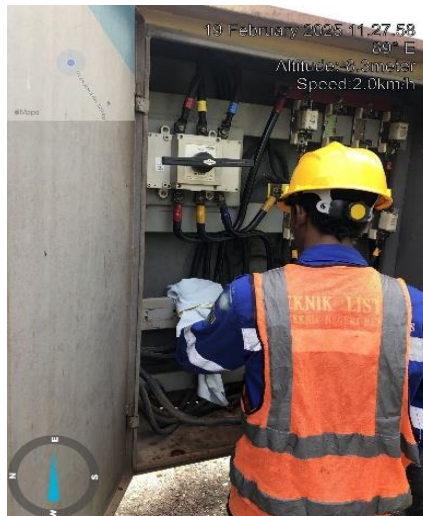
Gambar 2.27 Pembersihan box panel/lasbor
