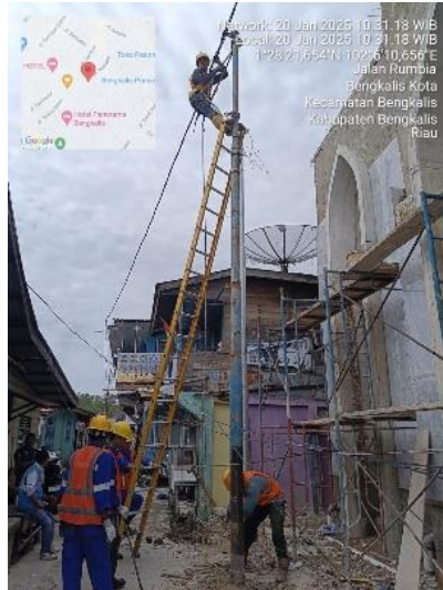
Gambar 2.8 Pemindahan tiang JTR
