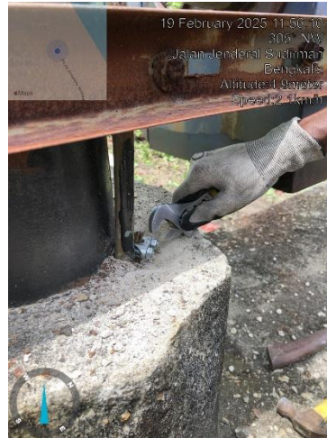
Gambar 2.50 Pemasangan grounding body
