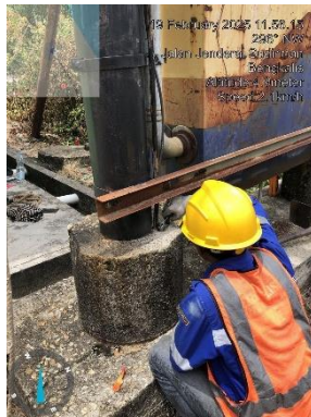
Gambar 3.3.17 Pemasangan grounding
