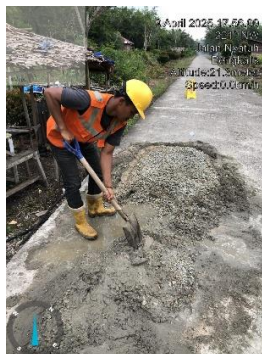
Gambar 2.62 Proses pengecoran
