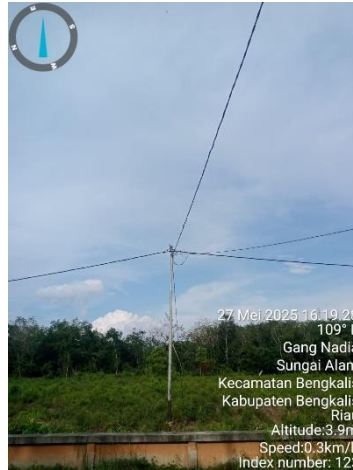
Gambar 2.107 Pemasangan kabel SKUTR
