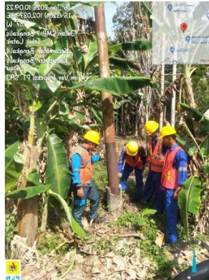
Gambar 2.3 Inspeksi JTM penyulang bandung(manset pecah)
