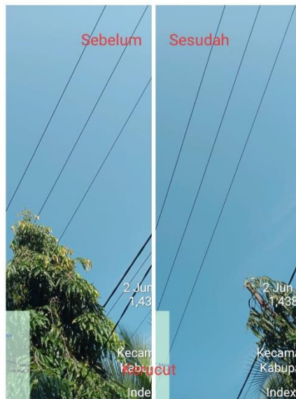
Gambar 2.109 Pemangkasan/ROW
