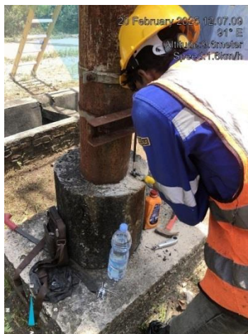
Gambar 2.35 Penguncian finik untuk grounding
