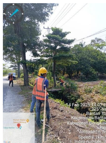
Gambar 2.25 Pemangkasan/Row
