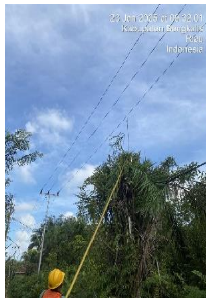
Gambar 2.13 Pemangkasan/Row
