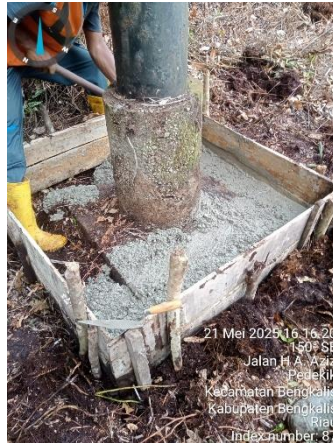
Gambar 2.46 Pengecoran manset
