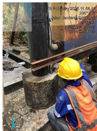
Gambar 2.28 Pengguncian finik untuk grounding
