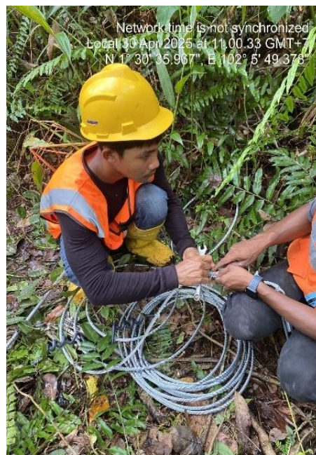
Gambar 2.85 Pemasangan kawat seling
