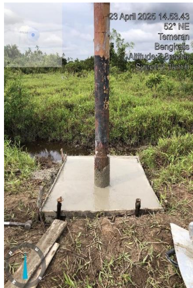
Gambar 2.74 Pengecoran manset
