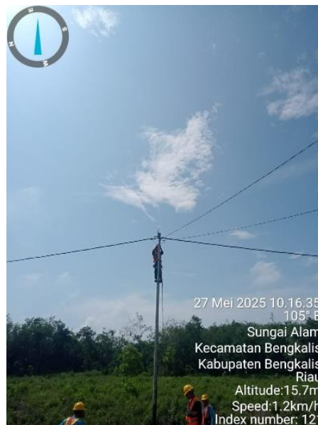
Gambar 2.106 Pemasangan kabel SR
