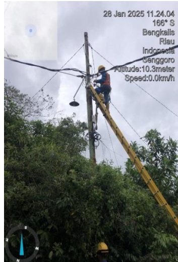
Gambar 2.14 Menaikkan kabel SKUTR
