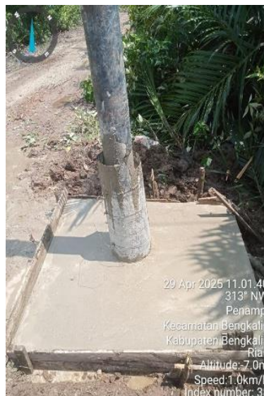
Gambar 2.79 Pengecoran manset
