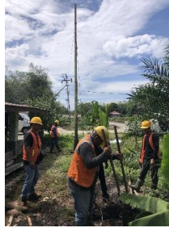
Gambar 2.60 Pemasangan beton track
