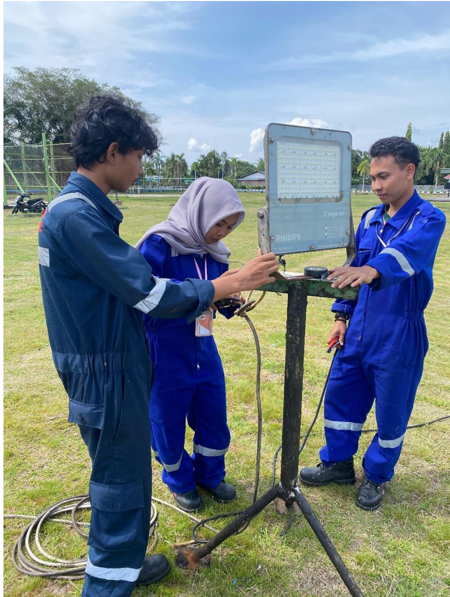
Gambar 3.6 pemasangan lampu penerangan
