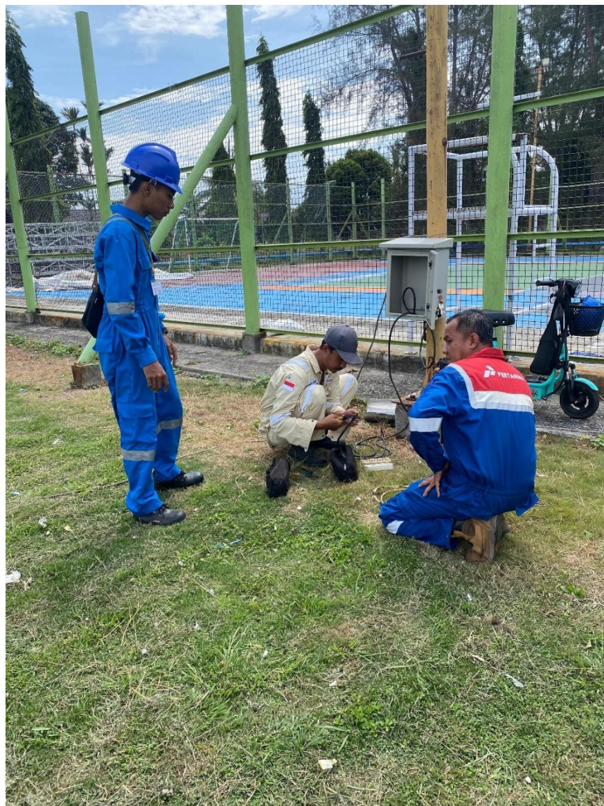
Gambar 3.8 pembongkaran panel dan cleaning
