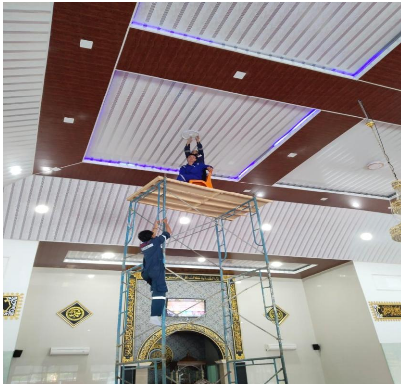
Gambar 3.10 perbaikan lampu penerangan di mushola Pertamina
