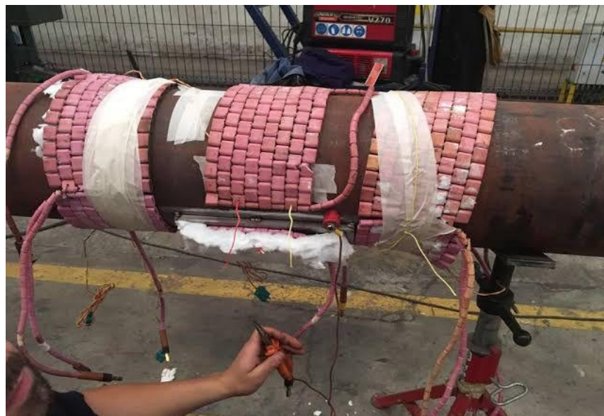
Gambar 3.34 pembongkaran pwht area dapur pembakaran
