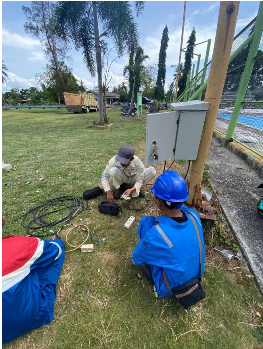
Gambar 3.7 pemasangan panel didepan kantor induk
