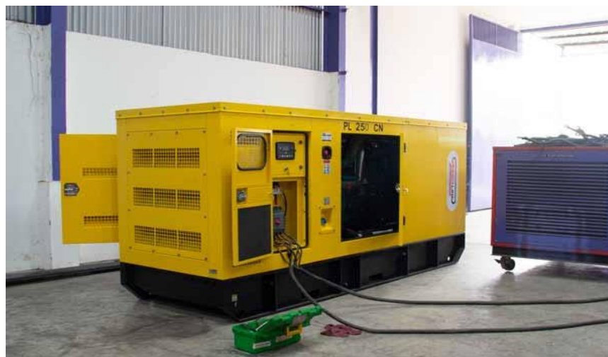
Gambar 3.5 pemasangan genset 250 kva
