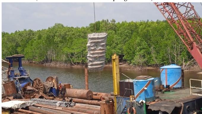
*Gambar 4. 7 Pengangkatan Boangkaran Beton Persegmen Menggunakan Crane*
