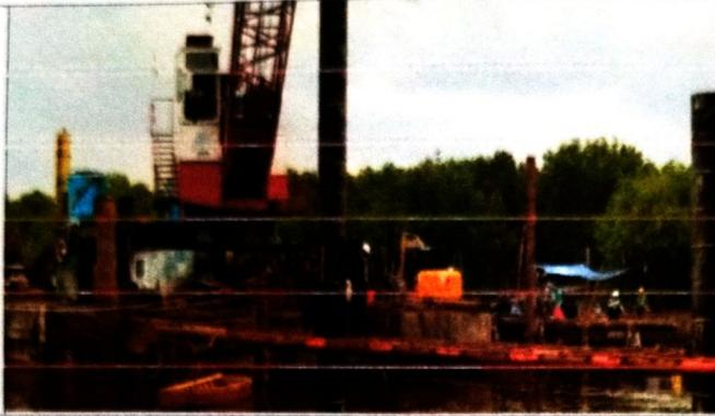
Pemasangan tiang pancang baja dilakukan menggunakan crane dan di letakkan di titik yang sudah direncanakan.
