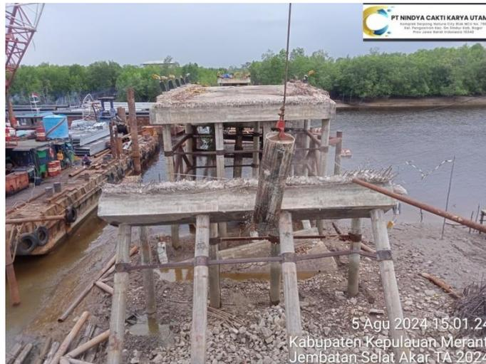
*Gambar 4. 16 Perobohan Pile Cab Dan Spun Pile Menggunakan Crane
