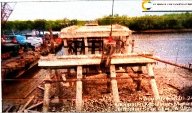
Pembongkaran segmen 4 tanjung padang menggunakan cutting torch untuk memotong tulangan dan crane untuk menghancurkan beton dan merubuhkan tiang pancang beserta pile slabnya.
