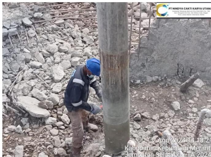
*Gambar 4. 15 Pemotongan Tiang Pancang Menggunakan Gerinda
