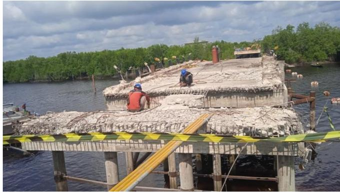
*Gambar 4. 14 Pemotongan Tulangan Pada Oprit Menggunakan Cutting Torch
