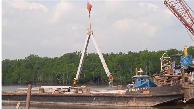
*Gambar 4. 10 Pindahan Rangka Baja Ke Tongkang Menggunakan Crane
