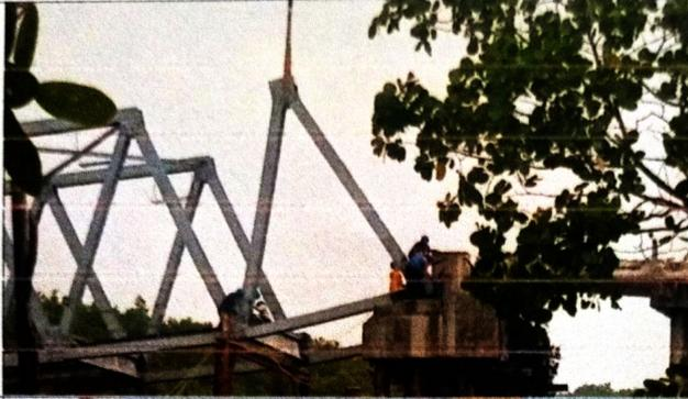
Pembongkaran rangka baja jembatan menggunakan crane untuk mengangkat dan memindahkan rangka ke tongkang.
