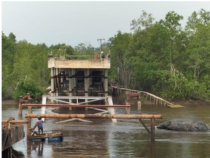
*Gambar 4. 18 Pemasangan Balon Pada Rangka Baja Terendam Air
