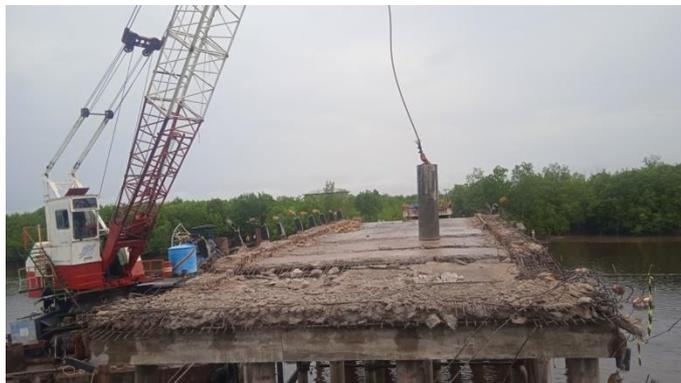
*Gambar 4. 13 Penghancuran Oprit Beton Menggunakan Crane
