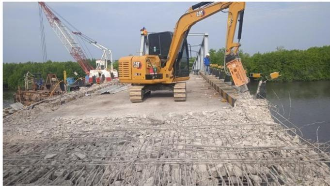
*Gambar 4. 12 Pembobokan Beton Menggunakan Escavator PC 75
