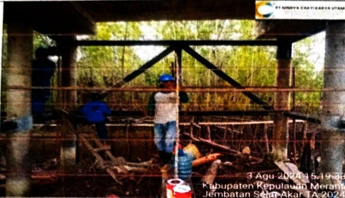
Pemasangan Bracing arah belitung berfungsi untuk penguat struktur saat melakukan pembongkaran beton pada segmen 5 dan 6, dan pada saat melakukan pemancangan.
