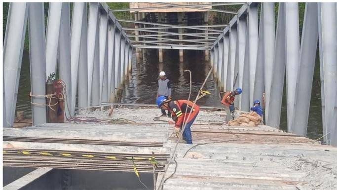
*Gambar 4. 8 Pembongkaran Plat Deck Jembatan
