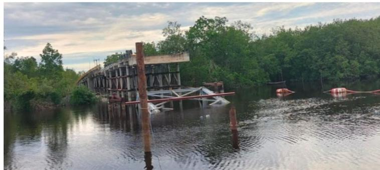
*Gambar 4. 11 Rangka Baja Jembatan Yang Jatuh Kesungai
