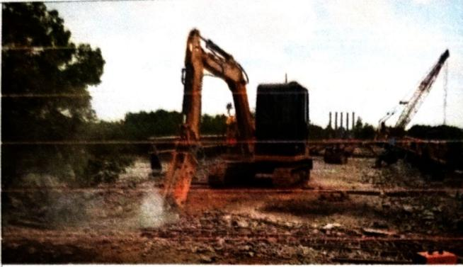
Pembongkaran segmen 5 dan 6 arah teluk Belitung dilakukan menggunakan escavator pc 75 sebagai alat penghancur beton.
