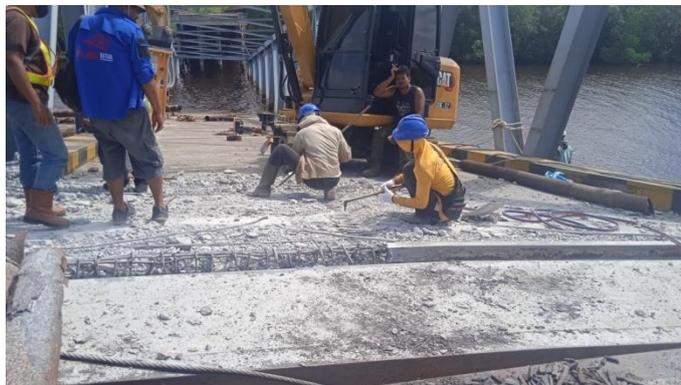
*Gambar 4. 6 Pembobokan dan Pematangan Tulangan pada Beto di Rangka Baja Jembatan (Sumber : Dokumentasi Lapangan 2024)*
