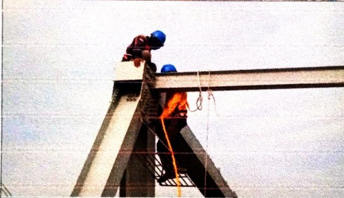
Pembongkaran rangka baja jembatan menggunakan bor impact untuk membuka baut satu persatu.
