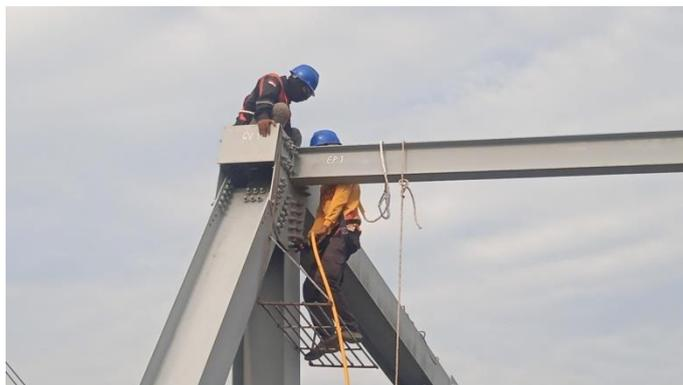
*Gambar 4. 9 Membuka Baut Pada Rangka Baja Menggunakan Bor Impact
