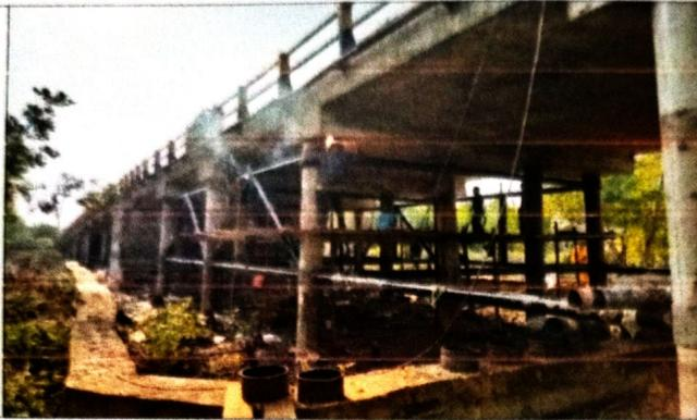
Pemasangan Bracing pada segmen 3 arah tanjung padang berfungsi untuk penguat struktur saat melakukan pembongkaran beton pada segmen 4 dan pemancangan.
