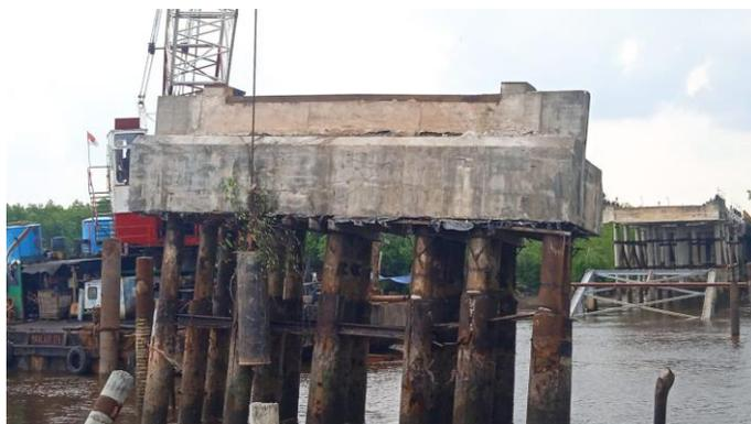
*Gambar 4. 17 Perobohan Pier Head Menggunakan Crane
