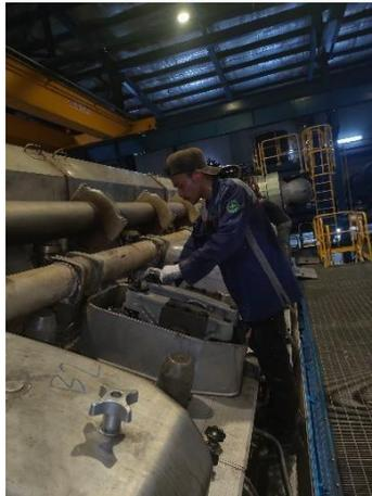
**Gambar 3. 69** *Clearens* Pada *Engine*
