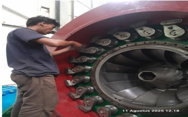
Proses pemasangan ARM Guide vane dan Guide vane rod pada Regulating ring
