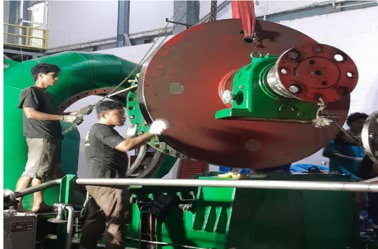
Proses pembongkaran/pengangkatan shaft dan flywheel turbin dari dudukan shaft turbin
