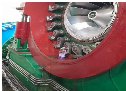
Gambar 4. 20 Pelumasan ARM Guide Vane Sumber Dokumen Pribadi
