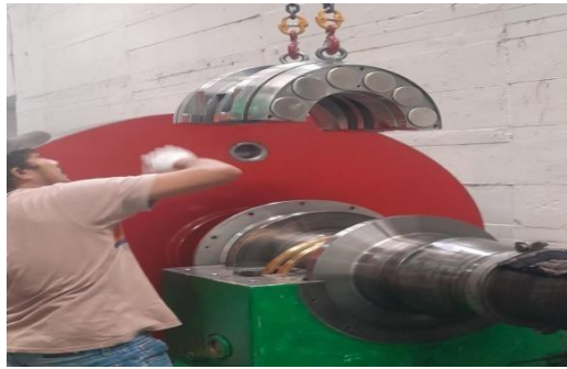
Gambar 4. 23 Proses penggantian/pemasangan bearing Sumber Dokumen Pribadi
