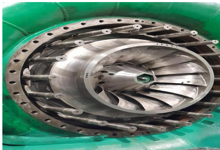
Pemasangan Guide vane (sudu-sudu pengarah) pada Spiral case (rumah turbin)
