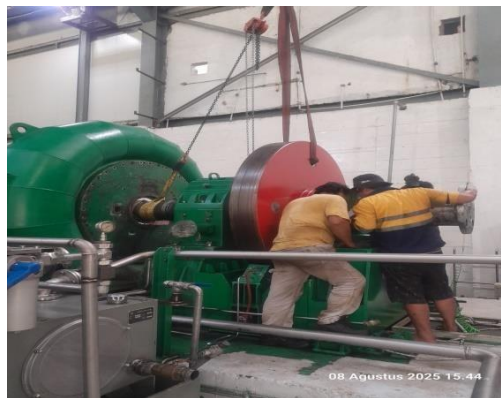
Gambar 4. 27 Perakitan ulang komponen turbin Sumber Dokumen Pribadi
