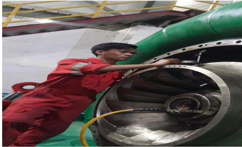
Pemasangan Runner (Sudu gerak) sekaligus pengungkuran celah Runner terhadap Spiral case (rumah turbin)
