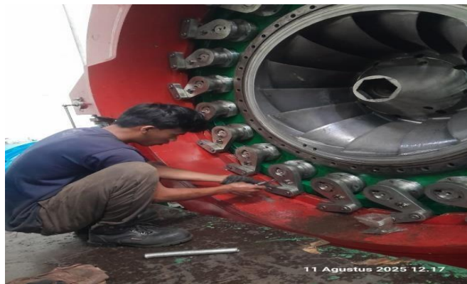
Pemasangan pin Penghubung dan Snap ring ARM guide vane
