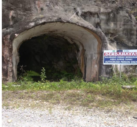
Gambar 4. 2 Terowongan ke Surge Tank Sumber: Dokumen Pribadi
