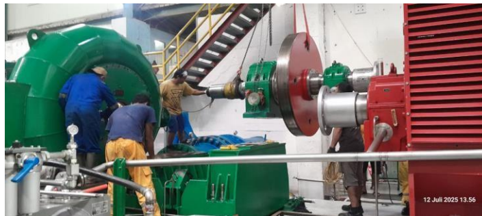
Gambar 4. 21 Pembongkaran turbin secara menyeluruh Sumber Dokumen Pribadi
