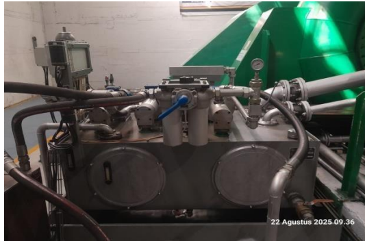
Gambar 4. 15 Pemeriksaan sistem lubrikasi Sumber Dokumen Pribadi
