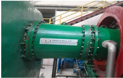
Gambar 4. 16 Pemeriksaan baut baut yang Longgar Sumber Dokumen Pribadi
