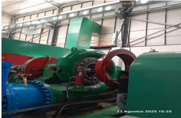
Proses pemasangan Regulating Ring pada spiral case (rumah turbin)
