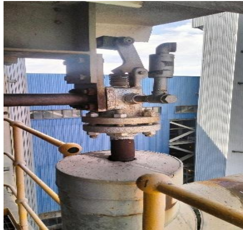
Gambar 4.8 Popet Valve (Sumber: Dokumentasi Pribadi)
