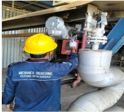
Gambar 4. 13 Pemeriksaan Gland packing (Sumber: Dokumentasi Pribadi)
