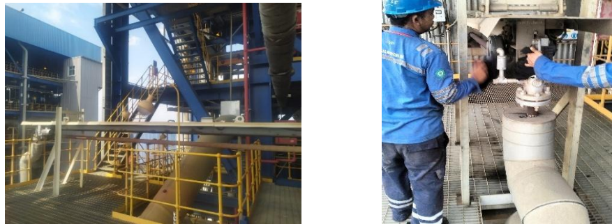
Gambar 4.1 Sootblower Long Dan semi Long (Sumber: Dokumentasi Pribadi)
