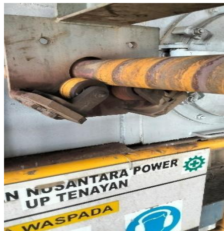
Gambar 4.7 Roller Support (Sumber: Dokumentasi Pribadi)
