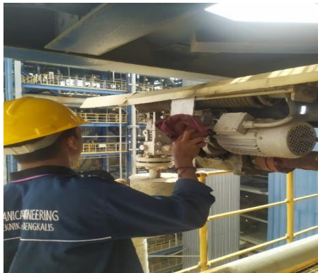
Gambar 4. 21 Pembersihan Bodi Sootblower (Sumber: Dokumentasi Pribadi)
