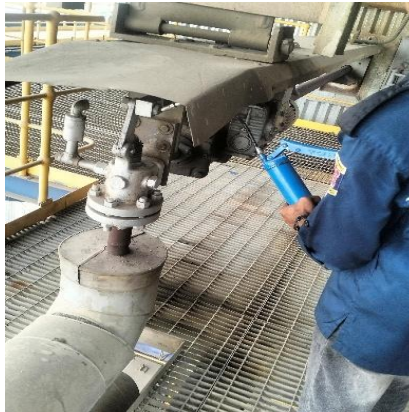
Gambar 4. 17 Pelumasan Pada Pegas (Sumber: Dokumentasi Pribadi)
