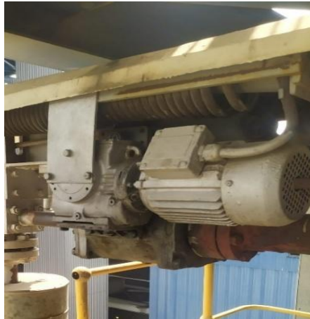
Gambar 4.3 Gearbox (Sumber: Dokumentasi Pribadi)
