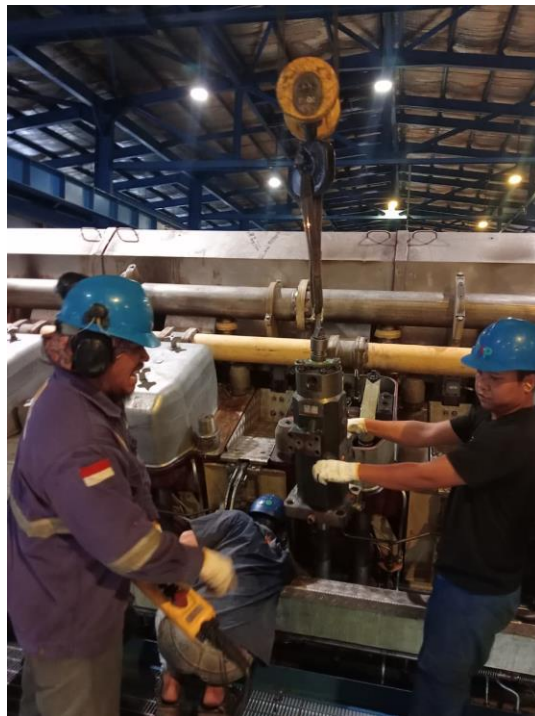
Lampiran 2 Mengangkat Injection Pump Menggunakan alat bantu (Crane)
