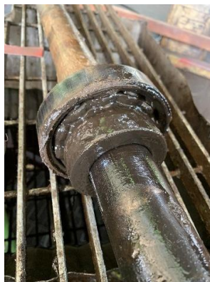
Gambar 4.14 Pembongkaran Bearing dan shaft pompa
