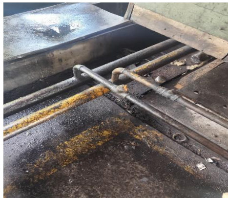
Gambar 4.7 Pipa Penyaluran Bahan Bakar
