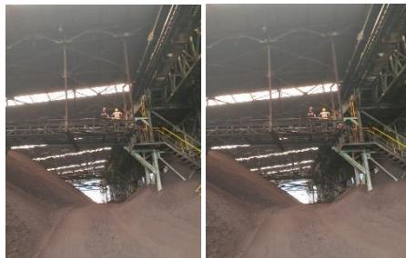
Gambar 3. 12 Penggantian rubber conveyor (Sumber Dokumentasi: PT. Power Plant)
