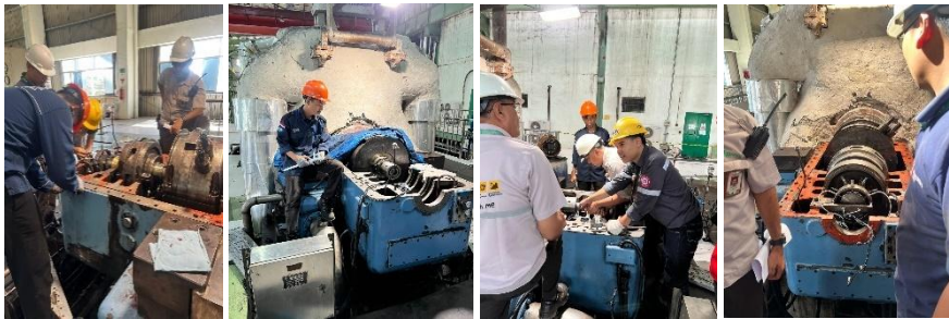
Gambar 3. 32 Assemblu kembali turbin 2 (Sumber Dokumentasi: PT. Power Plant)
