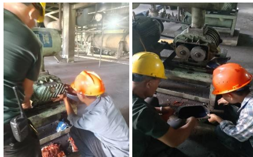
Gambar 3. 2 Pembongkaran RAF ( Roots Air Fan ) Sumber: Dokumentasi: PT. Power Plant)
