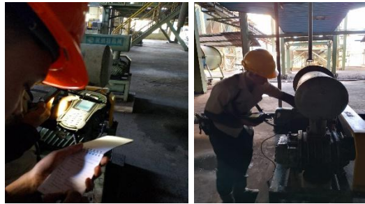
Gambar 3. 1 RAF (Roots Air Fan) (Sumber Dokumentasi: PT.Power Plant)
