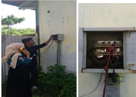
Gambar 3. 2 Perbaikan Jaringan Telepon DI Perumahan kilang PT Pertamina
