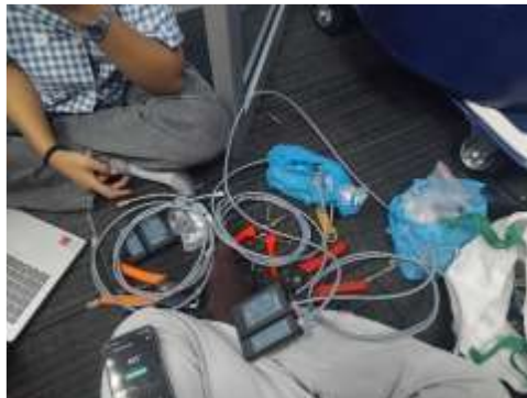
Gambar 3.28 Pembuatan Kabel LAN
