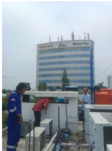
Gambar 3.37 Survei Lokasi Pemasangan
