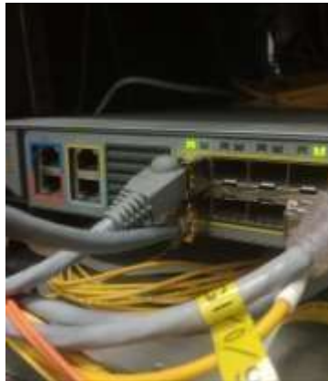
Gambar 3.33 Pemasangan Media Converter
