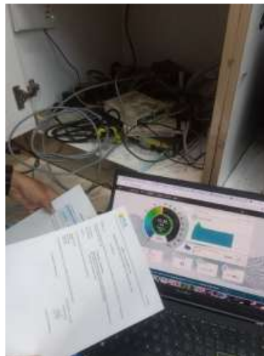
Gambar 4.6 Dokumen Pekerjaan Selesai
