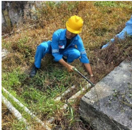
Gambar 3.1 Pemasangan Line Pipa Air (Sumber: Dokumentasi Lapangan, 2024)
