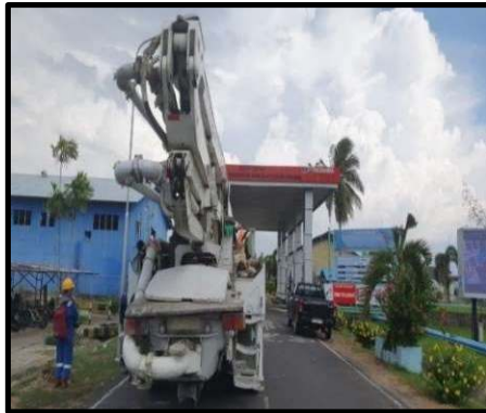
Gambar 3.13 Proses Mobilisasi Mobil concrete pump menuju lokasi titik galian bore pile tadi, kemudian dilanjutkan proses dimana lengan concrete pump diarahkan ke titik galian bore pile.
