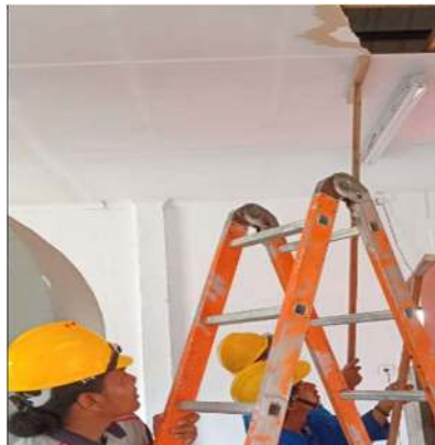
Gambar 3.3 Perbaikan plapon area Power (Sumber: Dokumentasi Lapangan, 2024)
