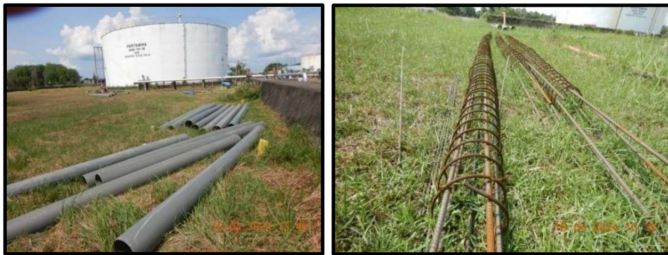
Gambar 3.9 Persiapan material sebelum dilakukan nya Penggalian, berupa pipa Casing PVC (AW) Dan tulangan untuk pengecoran bore pile, untuk pipa casing diamtere 30cm, kemudian ada 5 batang tulangan utama diameter 16mm dan tulangan Sengkang diameter 10mm, jarak pemasangan Sengkang 150mm antara lilitan
