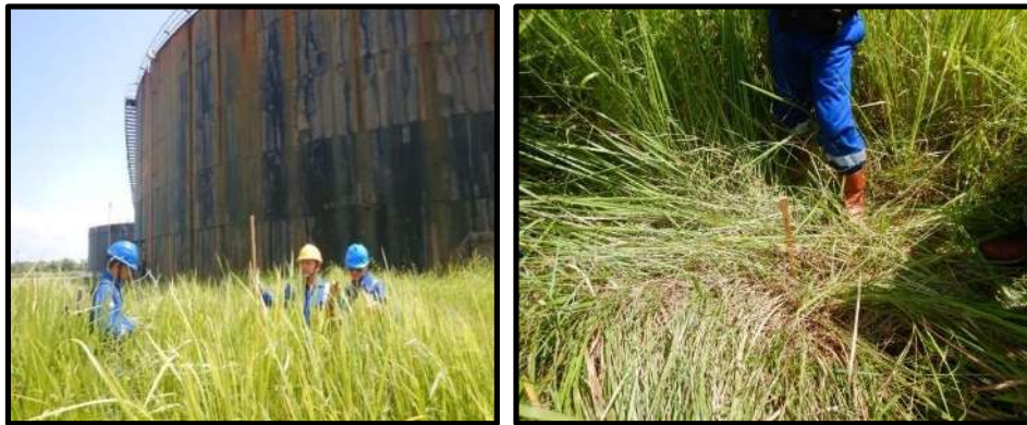
Gambar 3.8 Survey lokasi titik bore pile dengan menggunakan waterpas, kemudian setelah titik kordinat di rasa sudah pas, dilanjutkan dengan pemasangan patok penanda titik yang akan digali.
