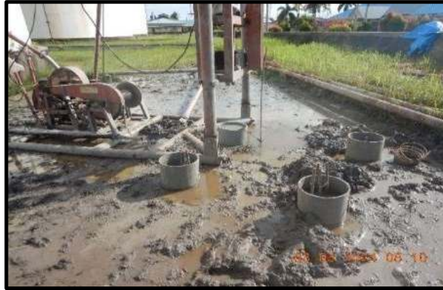
Gambar 3.12 setelah selesai pengeboran dan install casing dan pembesian, selanjutnya akan dilakukan tahap pembersihan baik pada lokasi, alat dan di area tempat proses pengeboran tadi supaya memudahkan pada saat pengecoran nanti.
