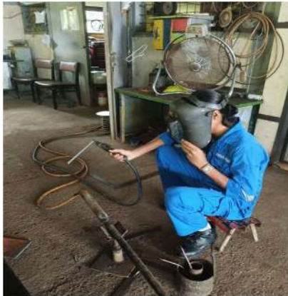
Gambar 3.2 Pengelasan pipa (Sumber: Dokumentasi Lapangan, 2024)
