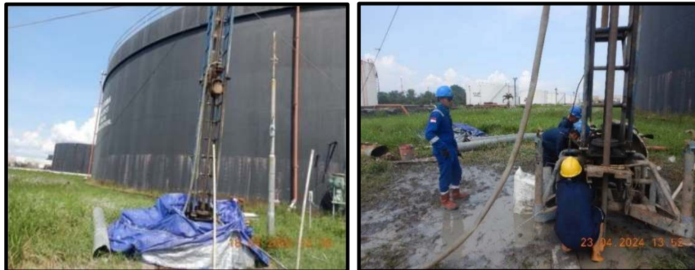
Gambar 3.11 setelah memposisikan mesin bore pile ke titik kordinatnya, kemudian para pekerja langsung memulai pengeboran sambil melihat karakteristik tanah apakah tanah, jika kondisi tanah buruk maka harus segera memasukkan full pipa casing dan jika kondisi tanah baik maka pasang pipa casing 6 meter saja kemudian dilanjutkan pengeboran hingga kedalaman 22,3 meter.
