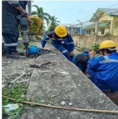
Gambar 3.5 penggantian line pipa air 2 inch (Sumber: Dokumentasi Lapangan, 2024)
