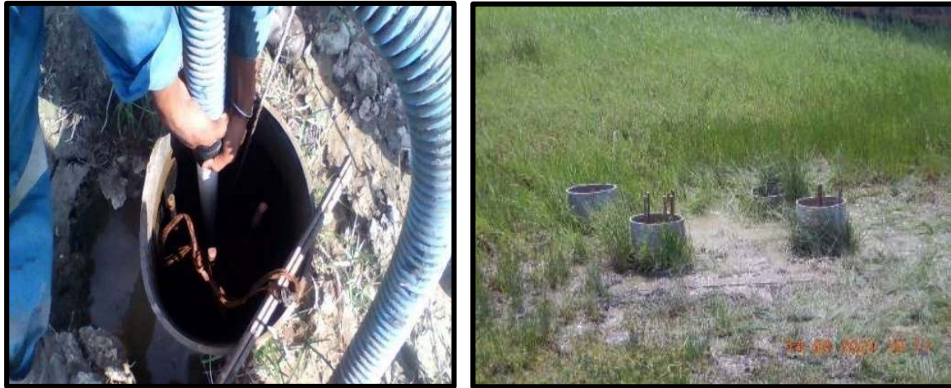
Gambar 3.14 Proses Pengisian beton ready mix k-350 kedalam lubang galian bore pile, Pada gambar ke dua hasil dari pengisian beton ready mix tadi yang sudah mengering (Sumber: Dokumentasi Lapangan, 2024)
