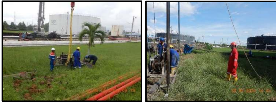
Gambar 3.10 Proses mobilisasi mesin bore pile dengan menggunakan mobile crane 160 ton menuju ke titik kordinat bore pile, kemudian Ketika sudah sampai ke titik yang ingin dilakukan pengeboran dilanjutkan dengan para pekerja melakukan persiapan pengeboran dengan memposisikan mesin bore pile ke titik kordinat yang ditentukan dengan diawasi oleh safety man.
