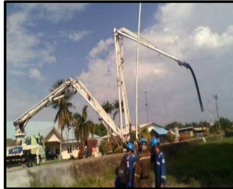
Gambar 3.13 Proses Mobilisasi Mobil concrete pump menuju lokasi titik galian bore pile tadi, kemudian dilanjutkan proses dimana lengan concrete pump diarahkan ke titik galian bore pile.
