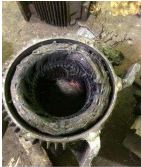
Gambar 3.42 Pembongkaran Emot Yang Kebakar (Sumber: Dokumentasi di PTPN IV Sei Buatan,2025)
