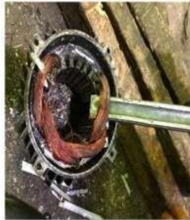
Gambar 3.39 Pembongkaran Emot Yang Kebakar (Sumber: Dokumentasi di PTPN IV Sei Buatn,2025)
