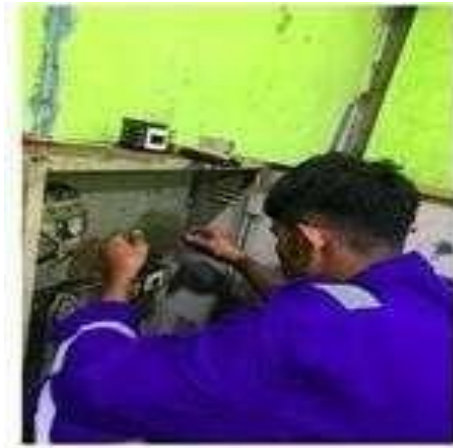
Gambar 3.16 Merangkai Star Delta (Sumber: Dokumentasi Di PTPN IV Sei Buat,2025)
