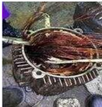
Gambar 3.50 Pembongkaran Emot Yang Kebakar (Sumber: Dokumentasi di PTPN IV Sei Buatan,2025)
