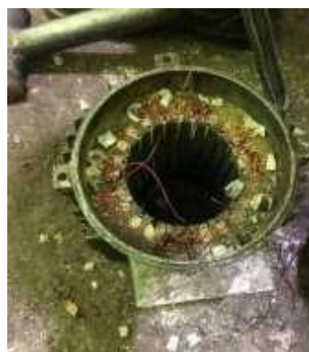
Gambar 3.33 Pembongkaran Emot Yang Kebakar (Sumber: Dokumentasi di PTPN IV Sei Buatan,2025)
