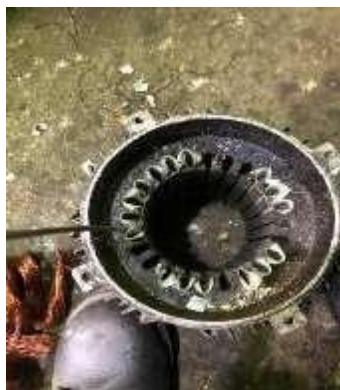
Gambar 3.32 Pembersihan Elmot (Sumber: Dokumentasi di PTPN IV Sei Buatan,2025)
