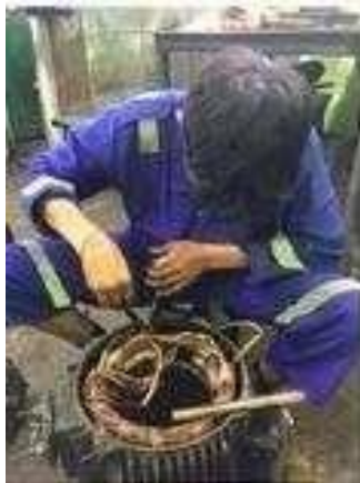
Gambar 3. 21 Pembongkaran Elmot Yang Terbakar (Sumber: Dokumentasi Di PTPN IV Sei Buatan,2025)
