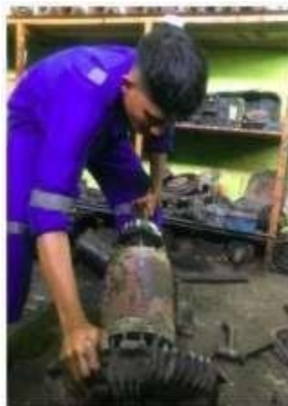
Gambar 3.55 penganti Bearing Elmot Waduk (Sumber: Dokumentasi di PTPN IV Sei Buatan,2025)
