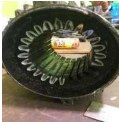
Gambar 3.46 Pembongkaran Emot Yang Kebakar (Sumber: Dokumentasi di PTPN IV Sei Buatan,2025)
