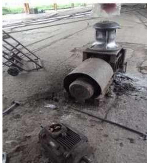
Gambar 3.38 Penggantian Elmot Kapstan (Sumber: Dokumentasi di PTPN IV Sei Buatan,2025)
