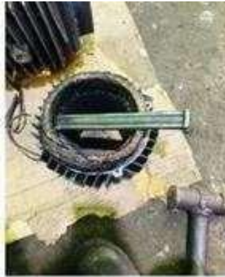
Gambar 3.45 Pembongkaran Emot Yang Kebakar (Sumber: Dokumentasi di PTPN IV Sei Buatan,2025)
