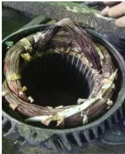
Gambar 3.60 Pembongkaran elmot (Sumber: Dokumentasi di PTPN IV Sei Buatan, 2025)
