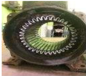
Gambar 3.19 Pemasangan Kertas Litroid Ke Elmot (Sumber: Dokumentasi Di PTPN IV Sei Buatan,2025)
