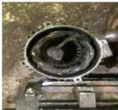
Gambar 3.57 pembongkaran elmot (Sumber: Dokumentasi di PTPN IV Sei Buatan, 2025)
