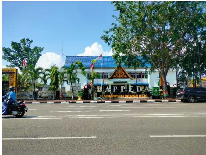
Gambar 2.1 kantor Bappeda Bengkulu (Sumber: Data Olahan)
