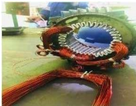
Gambar 3.43 Pemasangan Lilitan Email Drat Ke Stator Elmot (Sumber: Dokumentasi Di PTPN IV Sei Buatan, 2025)
