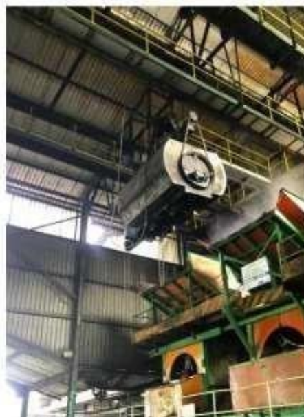
Gambar 4.4 Gambar Hoist Crane (Sumber:PTPN IV Sei Buatan 2025)
