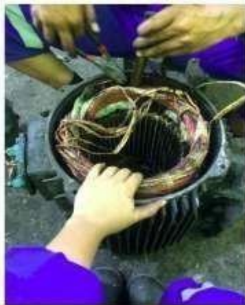
Gambar 3.14 Pembongkaran Elmot Yang Terbakar (Sumber: Dokumentasi Di PTPN IV Sei Buatan, 2025)
