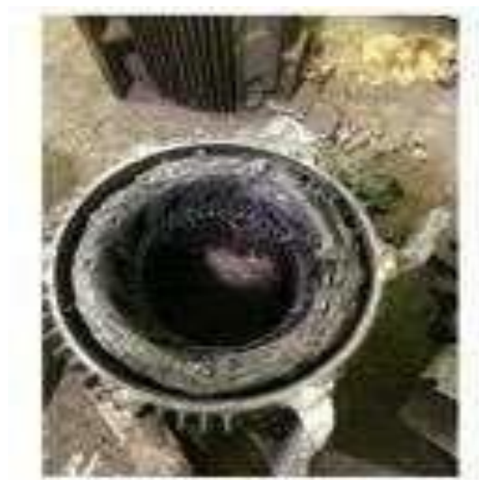
Gambar 3.23 Pembongkaran Elmot Yang Terbakar (Sumber: Dokumentasi Di PTPN IV Sei Buatan,2025)
