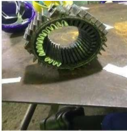
Gambar 3.56 Pemasangan Kertas Litroid Ke Elmot (Sumber: Dokumentasi Di PTPN IV Sei Buatan,2025)
