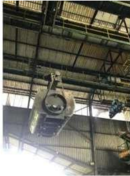
Gambar 4.3 Gambar Hoist Crane (Sumber:PTPN IV Sei Buatan 2025)
