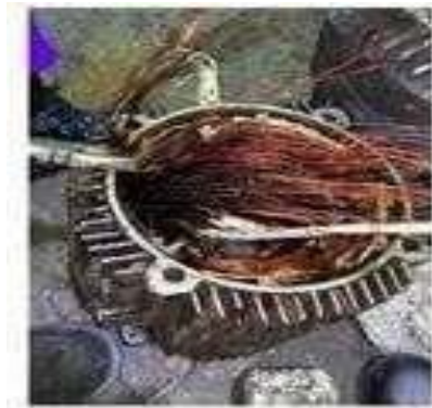
Gambar 3.30 Pembongkaran Liliran Elmot Yang Terbakar (Sumber: Dokumentasi Di PTPN IV Sei Buatan,2025)
