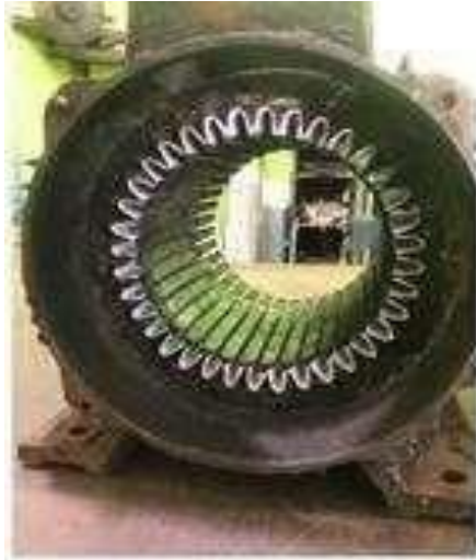
Gambar 3.47 Pemasangan kertas litroid ke Elmot (Sumber: Dokumentasi di PTPN IV Sei Buatan, 2025)
