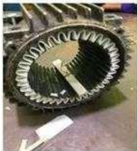
Gambar 3.49 Pemasangan Kertas Litroid Ke Elmot (Sumber: Dokumentasi Di PTPN IV Sei Buatn,2025)
