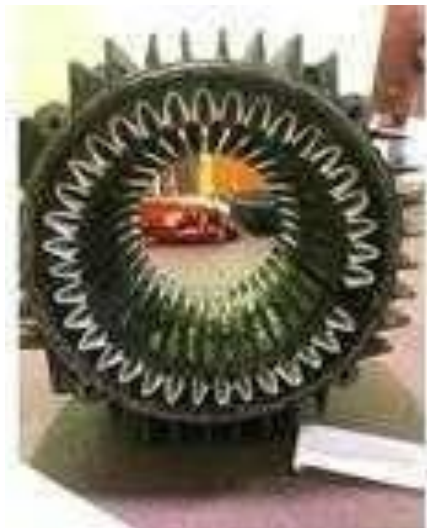
Gambar 3.15 Pemasangan Kertas Litroid Ke Elmot (Sumber: Dokumentasi Di PTPN IV Sei Buatan, 2025)
