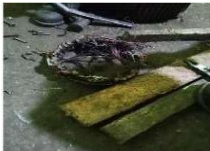
Gambar 3.54 Pembongkaran Lilittan Elmot Yang Terbakar (Sumber: Dokumentasi Di PTPN IV Sei Buatan,2025)
