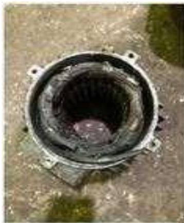
Gambar 3.34 Pembongkaran Lilitan Elmot Yang Terbakar (Sumber: Dokumentasi Di PTPN IV Sei Buat,2025 )
