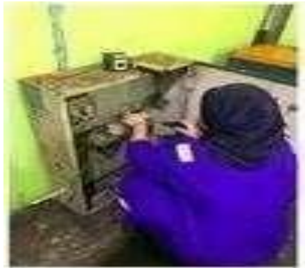
Gambar 3.16 Merangkai Star Delta (Sumber: Dokumentasi Di PTPN IV Sei Buatan,2025)
