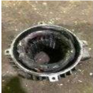
Gambar 3.12 Pembongkaran Elmot Yang Terbakar (Sumber: PTPN IV Sei Buatan,2025Dokumentasi di)
