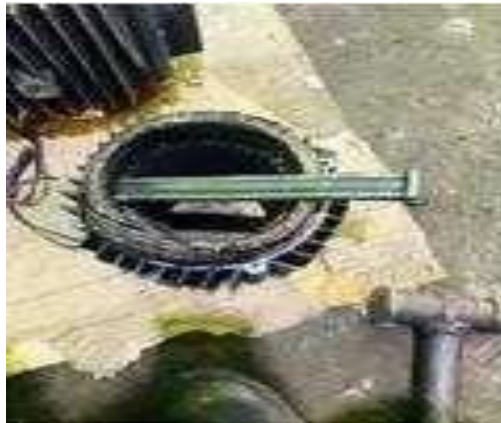
Gambar 3.45 Pembongkaran Lilittan Elmot Yang Terbakar (Sumber: Dokumentasi Di PTPN IV Sei Buatan,2025)
