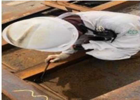
Gambar 2 12 Pengecekan Las Sudut
