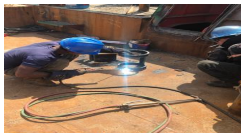
Gambar 2 48 Pembuatan Kedudukan Apar
