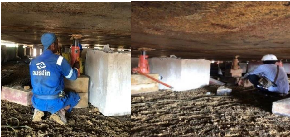
Gambar 2 15 Proses Pengejekan Plat Bottom
