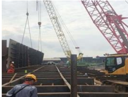
Gambar 2 10 Pemasangan Long Bulkhead
