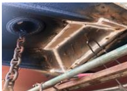
Gambar 2 61 Uji Penetran Test
