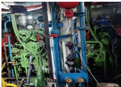
Gambar 2 36 Pengecekan Pada Bagian Perpipaan
