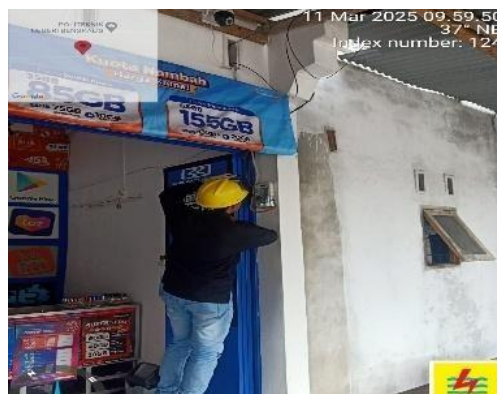
Gambar 3. 17 pemeriksaan Kwh meter pelanggan (Sumber: Dokumentasi, 2025)
