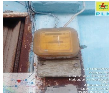
Gambar 3. 35 Kwh meter tua. (Sumber: Dokumentasi, 2025)
