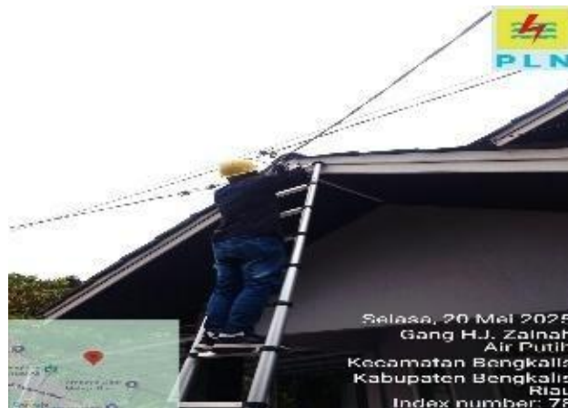
Gambar 3. 36 pengecekan arus bocor. (Sumber: Dokumentasi, 2025)
