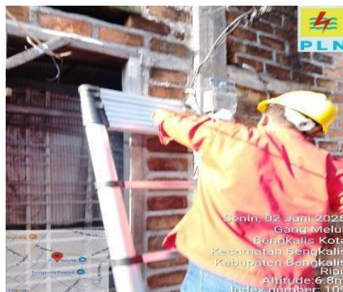
Gambar 3. 42 pergantian Kwh meter. (Sumber: Dokumentasi, 2025)
