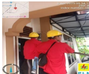
Gambar 3. 24 pemeriksaan Kwh meter pelanggan. (Sumber: Dokumentasi,2025)
