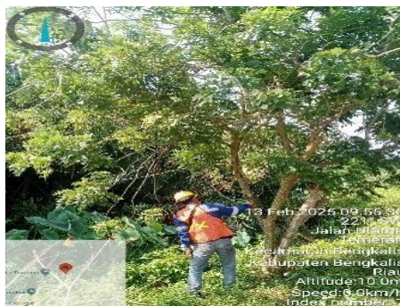
Gambar 3. 6 pemangkasan pohon proteksi jaringan. (Sumber: Dokumentasi, 2025)
