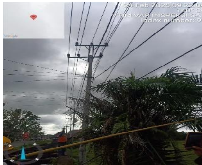
Gambar 3. 12 perbaikan gangguan jtm (Sumber: Dokumentasi, 2025)
