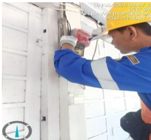
Gambar 3. 3 pergantian meter sementara (Sumber: Dokumentasi ,2025)
