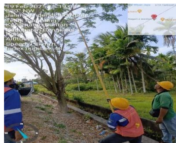
Gambar 3. 9 pemangkasan pohon proteksi jtm. (Sumber: Dokumentasi2025)
