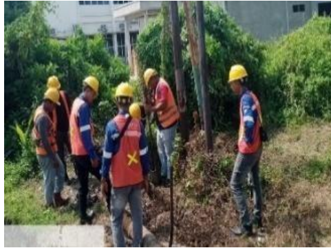
Gambar 3. 7 pemasangan tiang jtm.. (Sumber: Dokumentasi, 2025)
