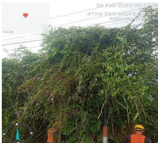
Gambar 3. 11 pemangkasan pohon proteksi jtm (Sumber: Dokumentasi, 2025)
