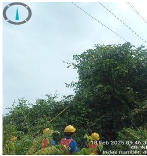
Gambar 3. 8 Pemangkasan pohon proteksi jtm. (Sumber: Dokumentasi,2025)
