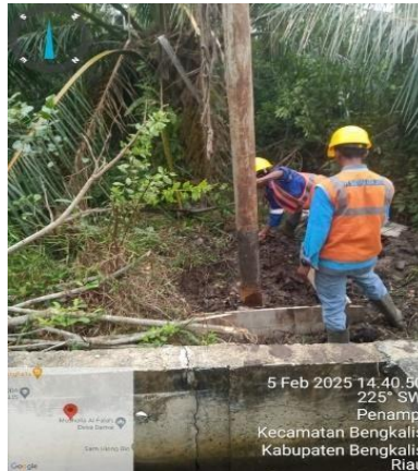
Gambar 3. 1 Pengecoran Tiang Jtm (Sumber: Dokumentasi 2025)
