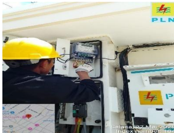
Gambar 3. 41 perbaikan fasa yang terbalik. (Sumber: Dokumentasi, 2025)
