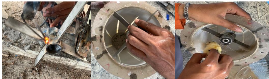
Gambar 4.26 Proses Pembuatan dan Pemasangan Dudukan bearing di Dalam Nozzle
