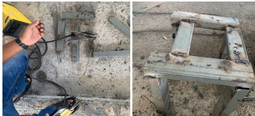
Gambar 4.30 Proses Pengelasan dan Dudukan Mesin yang sudah di Las
