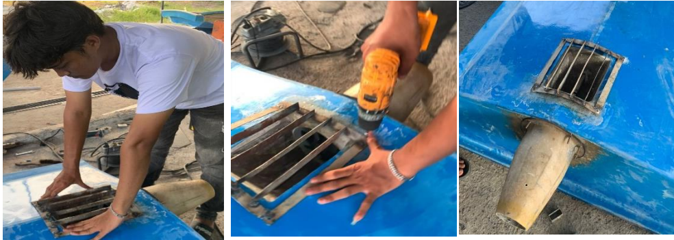
Gambar 4.28 Proses Pemasangan Saringan pada Intake Water Jet
