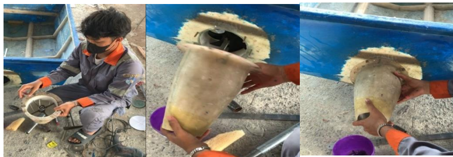
Gambar 4.27 Pemasangan Shaf dan Nozzle pada Sistem Water Jet
