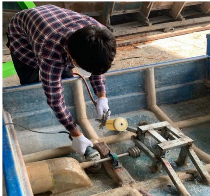
Gambar 4.33 Pembersihan Area Sekitar Dudukan Mesin Sebagai Persiapan Pengecatan
