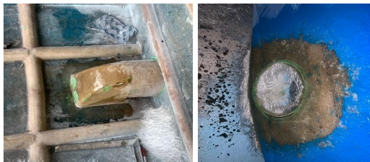
Gambar 4.21 Hasil Pemasangan dan Laminasi Komponen Intake pada Buritan Kapal
