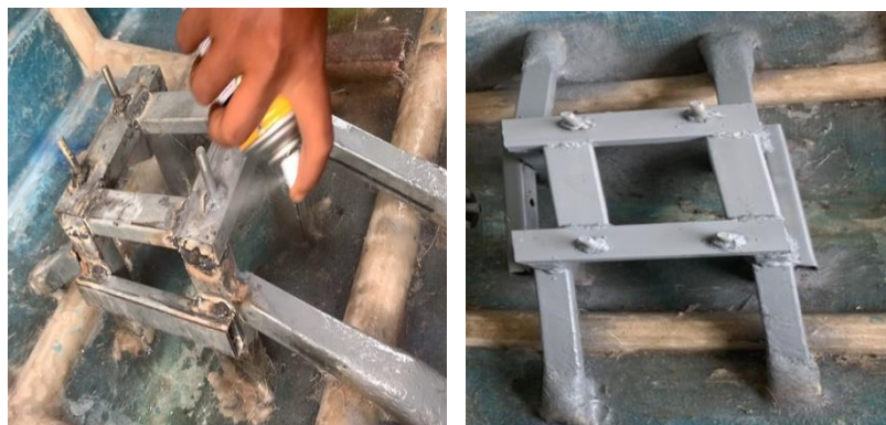
Gambar 4. 34 Tahap Pengecatan dan Hasil Akhir Dudukan Mesin Setelah Finishing
