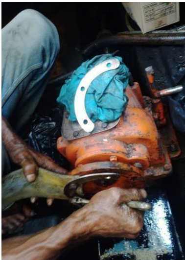
1.10 Pemasangan Selang Pompa Siput
