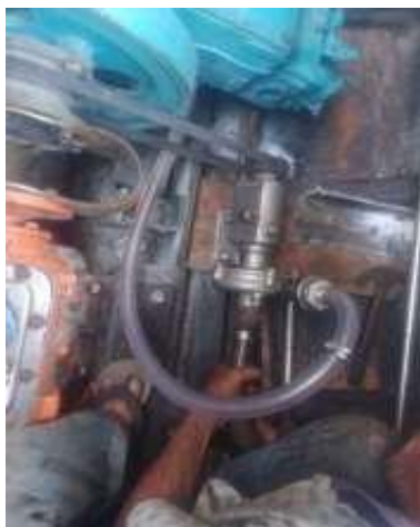
1.11. Penggerindaan Kedudukan Mesin
