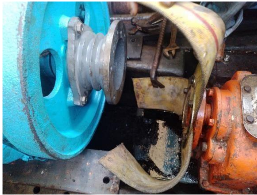
1.7 Pemasangan Plat di Kedudukan Mesin
