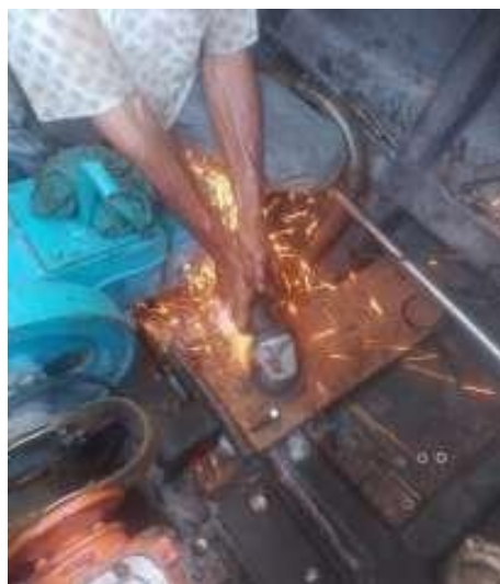
1.9 Pemasangan Semua Baut
