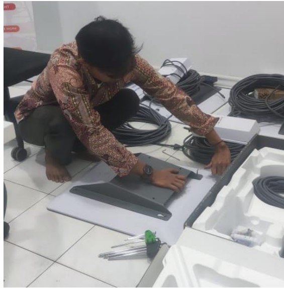
Gambar 4. 3 Pemasangan Bracket Mounting di Dalam Ruangan
