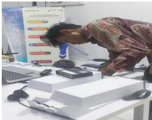
Gambar 4. 6 Pemasangan Router dan Sambungan Daya
