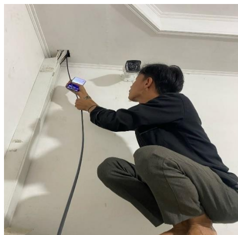
Gambar 3. 23 Membuat jalur kabel LAN diatas plafon
