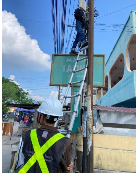
Gambar 3. 9 Pengecekan redaman di splitter
