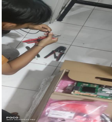
Gambar 3. 24 Pemasangan RJ dikabel LAN dengan alat Tang Crimping
