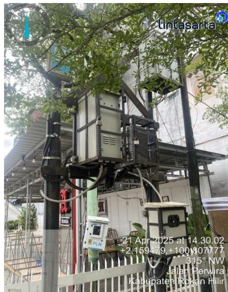
Gambar 3. 14 Preventive maintenance rutin bulanan pelanggan bagansiapiapi
