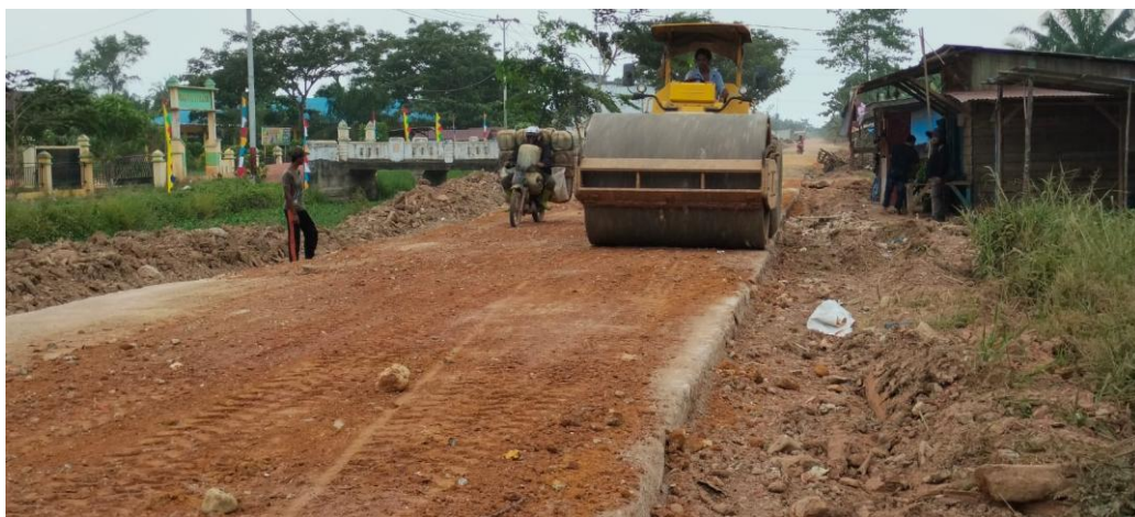
Gambar 3.15 Sumber Dokumentasi Lapangan Peningkatan Jalan Poros 2024, Teja Suhada
