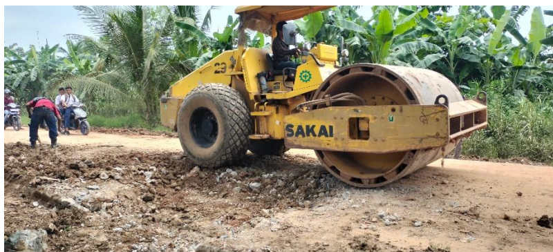
Gambar 3.11 Sumber Dokumentasi Lapangan Peningkatan Jalan Poros 2024, Teja Suhada
