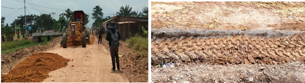
Gambar 3.14 Sumber Dokumentasi Lapangan Peningkatan Jalan Poros 2024, Teja Suhada
