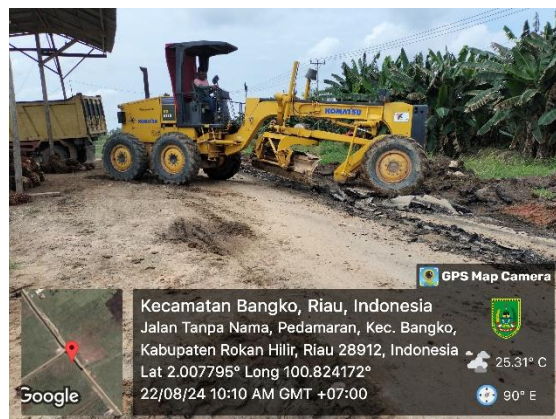
Gambar 4.2 Sumber Dokumentasi Lapangan Peningkatan Jalan Poros 2024, Teja Suhada
