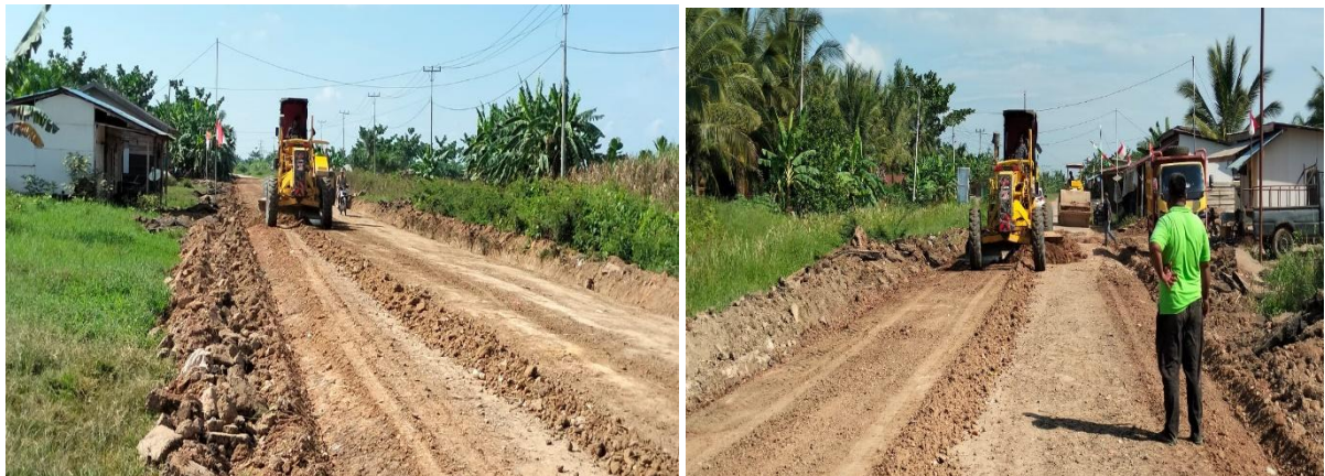
Gambar 3.7 Sumber Dokumentasi Lapangan Peningkatan Jalan Poros 2024, Teja Suhada
