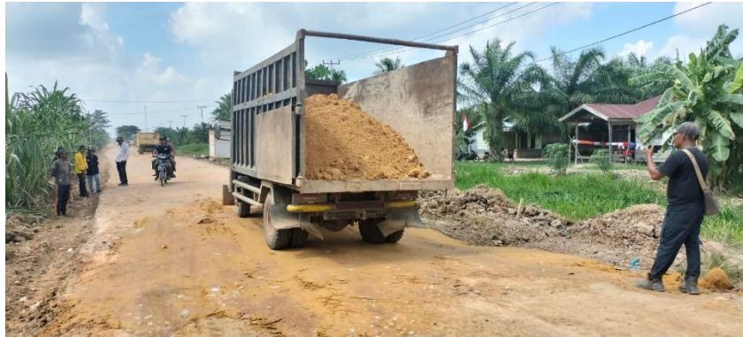
Gambar 3.12 Sumber Dokumentasi Lapangan Peningkatan Jalan Poros 2024, Teja Suhada
