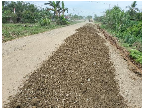
Gambar 4.1 Sumber Dokumentasi Lapangan Peningkatan Jalan Poros 2024, Teja Suhada
