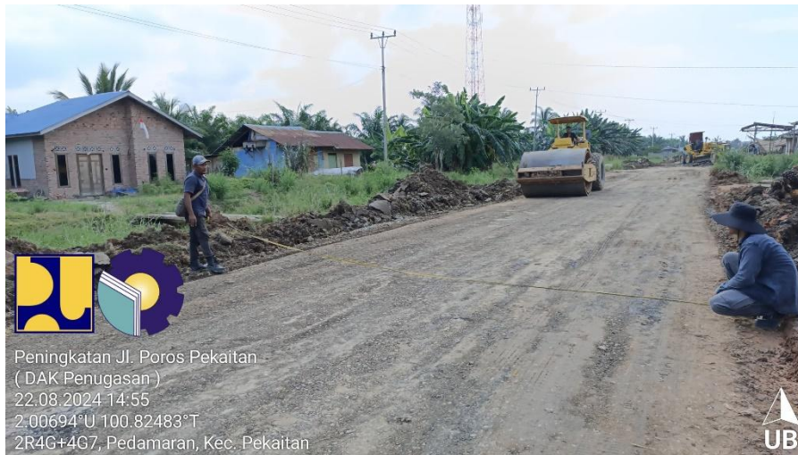
Gambar 3.1 Sumber Dokumentasi Lapangan Peningkatan Jalan Poros 2024, Teja Suhada
