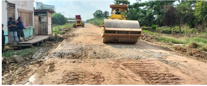
Gambar 3.4 Sumber Dokumentasi Lapangan Peningkatan Jalan Poros 2024, Teja Suhada
