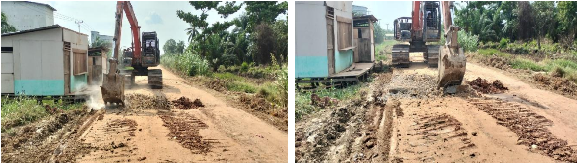
Gambar 3.2 Sumber Dokumentasi Lapangan Peningkatan Jalan Poros 2024, Teja Suhada
