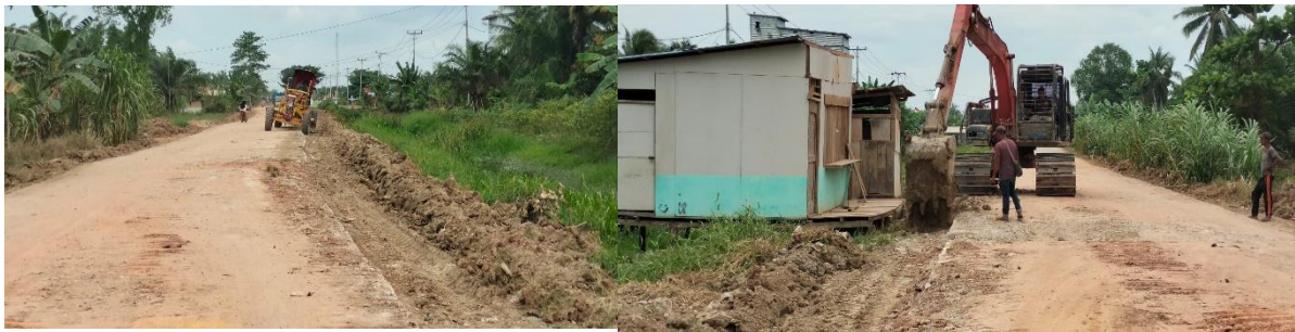
Gambar 3.5 Sumber Dokumentasi Lapangan Peningkatan Jalan Poros 2024, Teja Suhada
