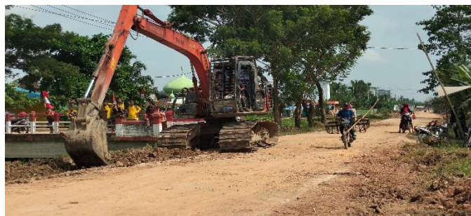
Gambar 3.9 Sumber Dokumentasi Lapangan Peningkatan Jalan Poros 2024, Teja Suhada
