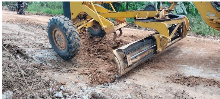
Gambar 3.3 Sumber Dokumentasi Lapangan Peningkatan Jalan Poros 2024, Teja Suhada
