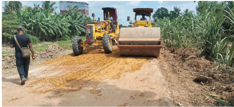
Gambar 4.3 Sumber Dokumentasi Lapangan Peningkatan Jalan Poros 2024, Teja Suhada
