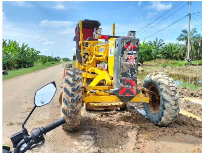
Gambar 3.10 Sumber Dokumentasi Lapangan Peningkatan Jalan Poros 2024, Teja Suhada
